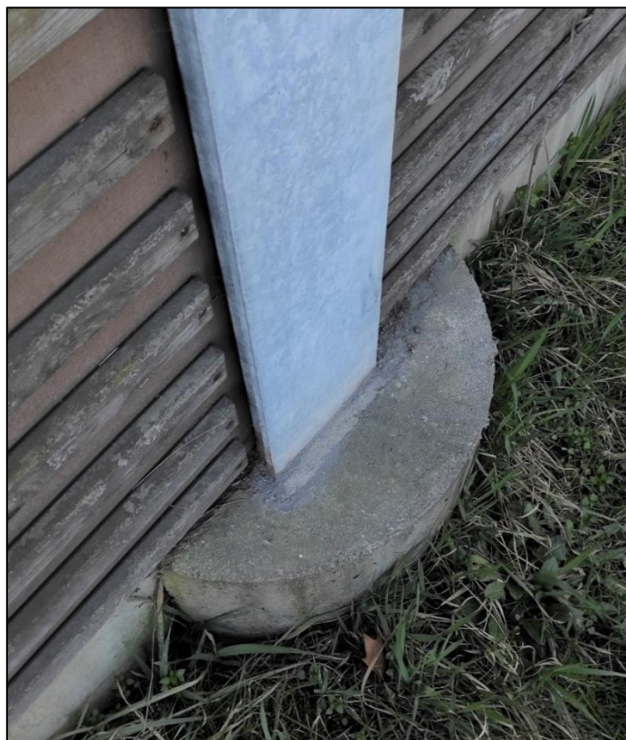
Slika 3. km 259 + 350.00 – izgled glave pilota i stupova
