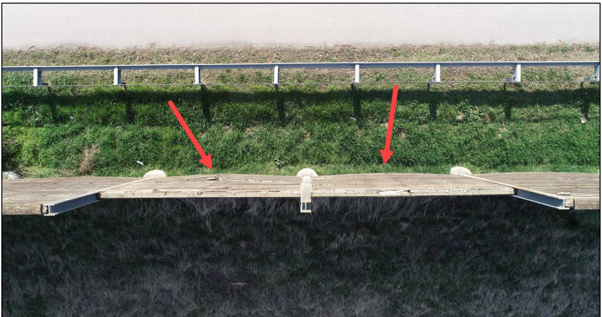
Slika 6. km 259+550.00 – izvitopereni paneli koji prijete da će ispasti
