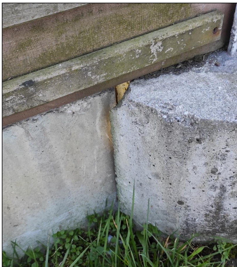
Slika 10. km 268+700 – otkrnuće glave pilota
