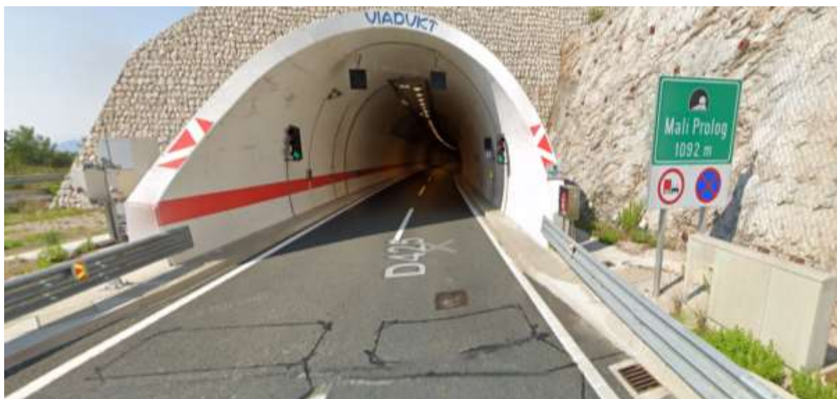
Slika 1. Južni portal desne tunelske cijevi tunel Mali Prolog
