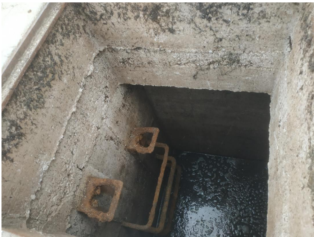
Slika 2: Postojeće stanje sabirne jame
