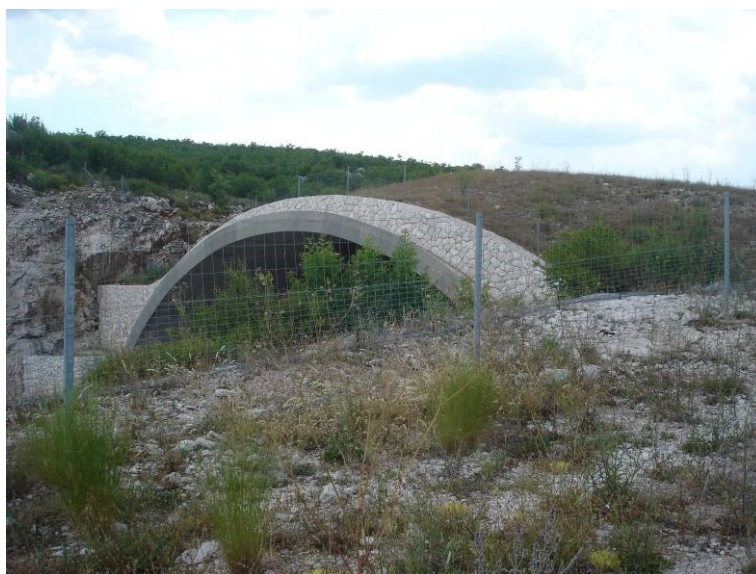
Slika 7. Kameno zemljani nasip u blagom luku iznad jugoistočnog portala
