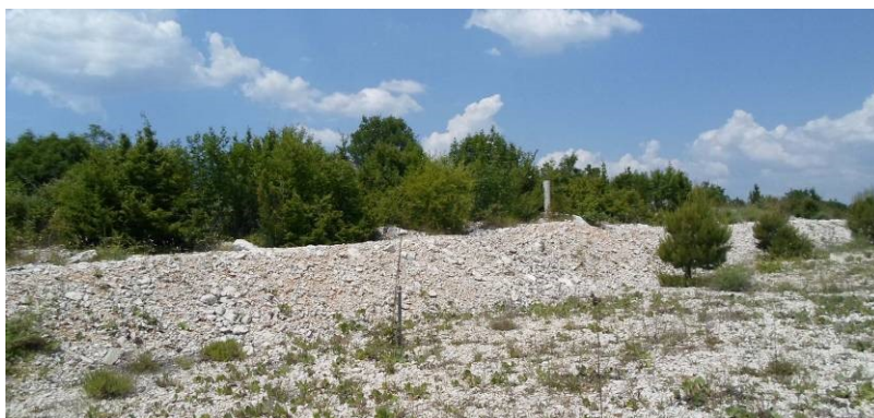
Slika 7. neprirodan i nedoravnat nasip prema prirodnom terenu , sanacija izvršena 2009. g.
