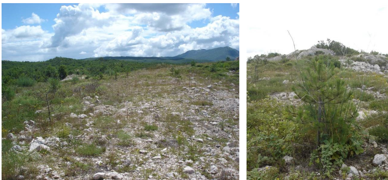
Slika 8. i 9. Kameno zemljani nasip zelenog mosta je zasađen sadnicama crnog bora ( Pinus nigra ) u pravilnom sklopu redova
