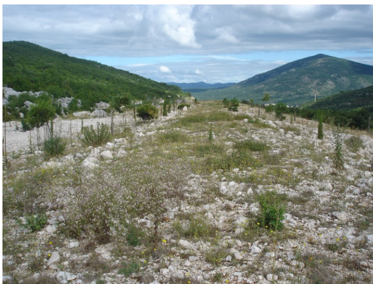
Slika 7. Kameno zemljani nasip zelenog mosta je zasađen sadnicama drveća u pet redova
