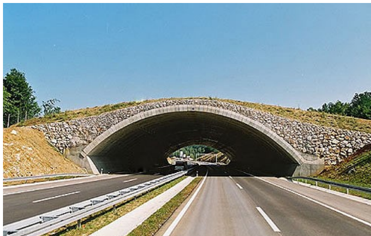
Slika 1. Pogled na jugoistočni portal zelenog mosta/umjetnog tunela Rasnica
