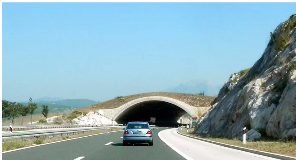
Slika 1. Pogled na sjeverozapadni portal zelenog mosta/umjetnog tunela Konščica
