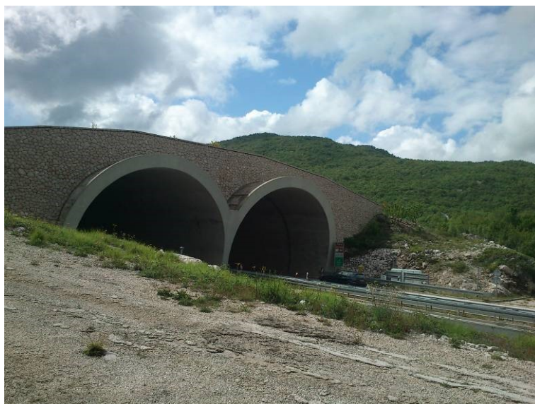
Slika 1. Pogled na sjeverozapadni portal zelenog mosta/umjetnog tunela Rošča
