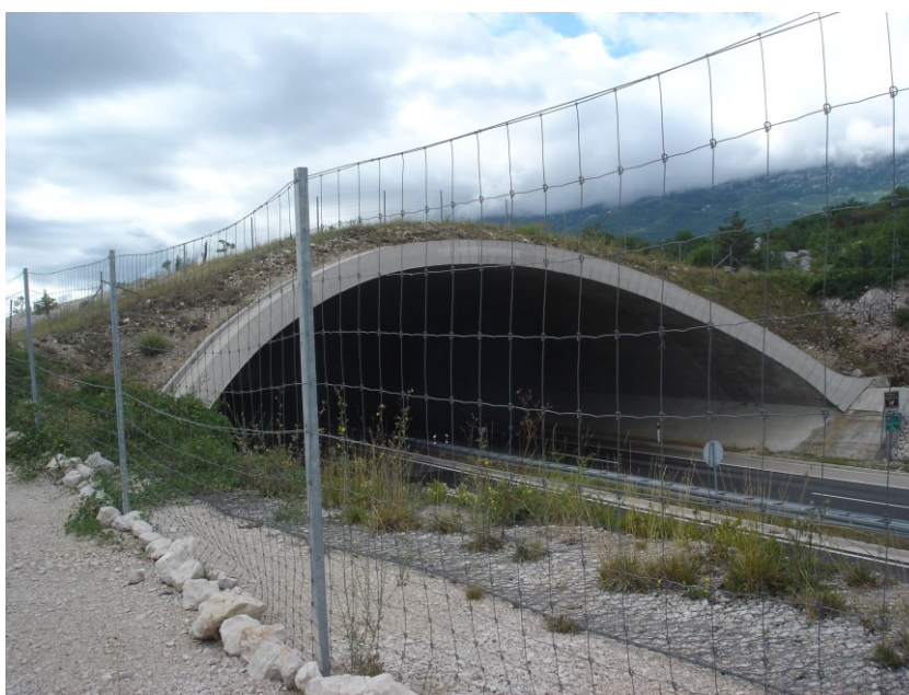
Slika 1. Pogled na zapadni portal zelenog mosta/umjetnog tunela Srednja Gora
