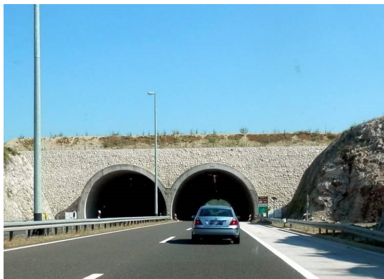
Slika 1. Pogled na sjeverozapadni portal zelenog mosta/umjetnog tunela Vrankovića ograda
