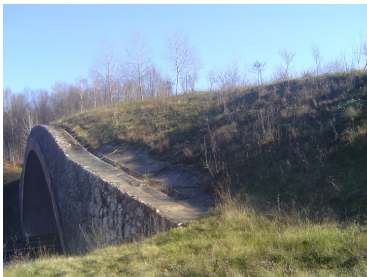
Slika 3. Zatravljeni nasip i vegetacija iznad sjeverozapadnog portala zelenog mosta Ivačeno brdo
