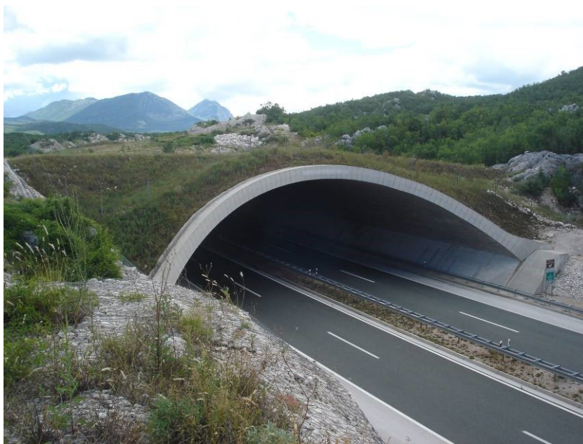
Slika 1. Pogled na zapadni portal zelenog mosta/umjetnog tunela Lendići
