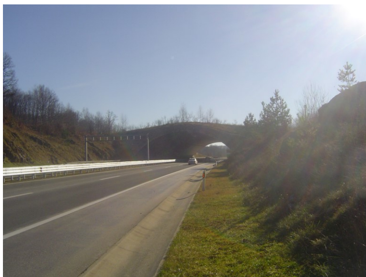
Slika 2. Pogled na sjeverozapadni portal zelenog mosta/umjetnog tunela Ivačeno brdo
