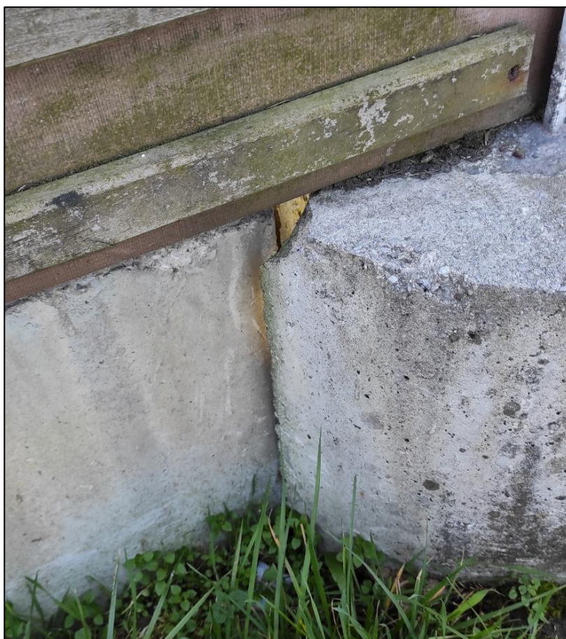
Slika 10. km 268+700 – otkrnuće glave pilota
