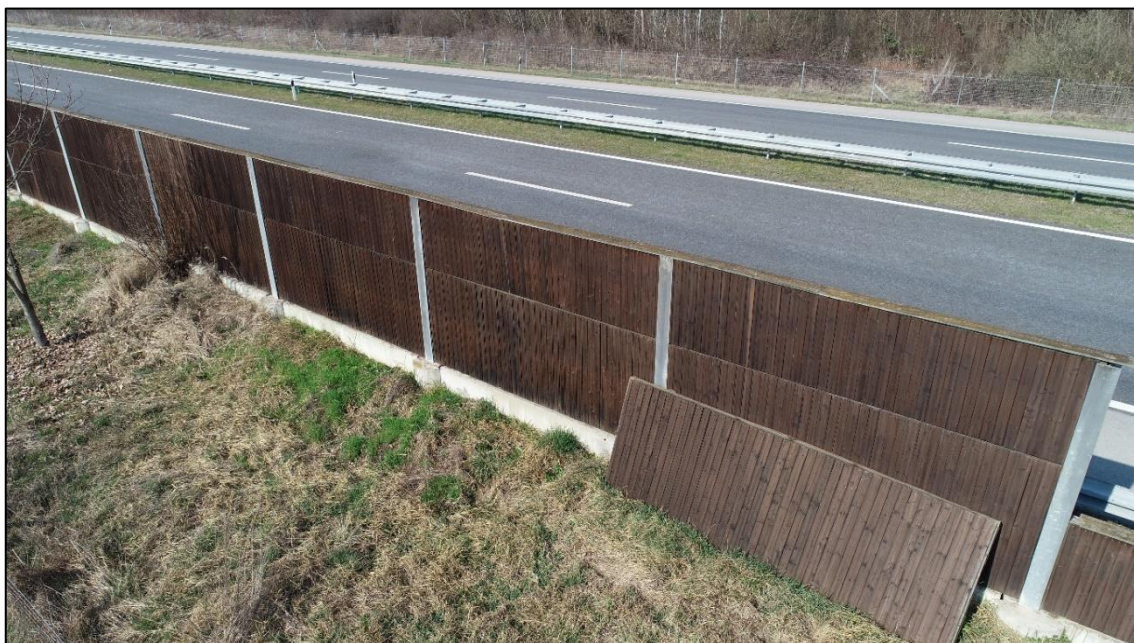
Slika 11. km 268+700.00 – stražnja strana zida za zaštitu od buke
