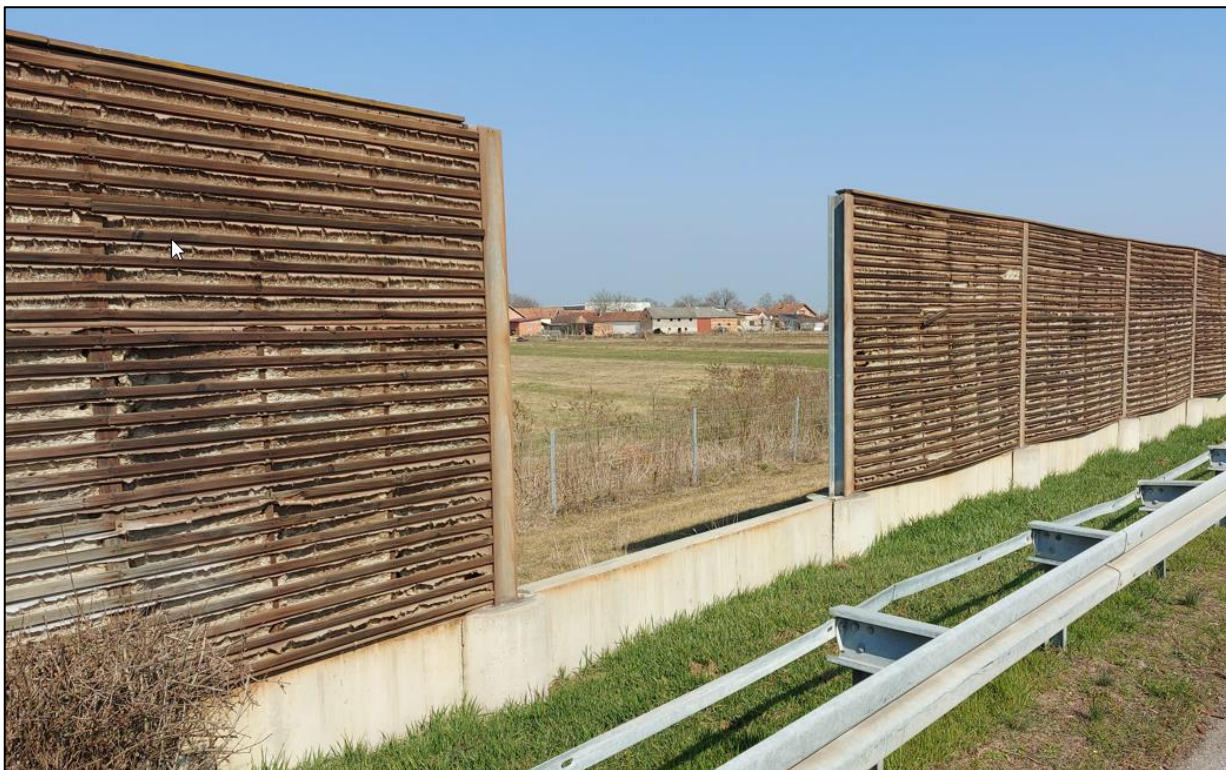
Slika 7. km 260+650 – polje na kojem nedostaju paneli
