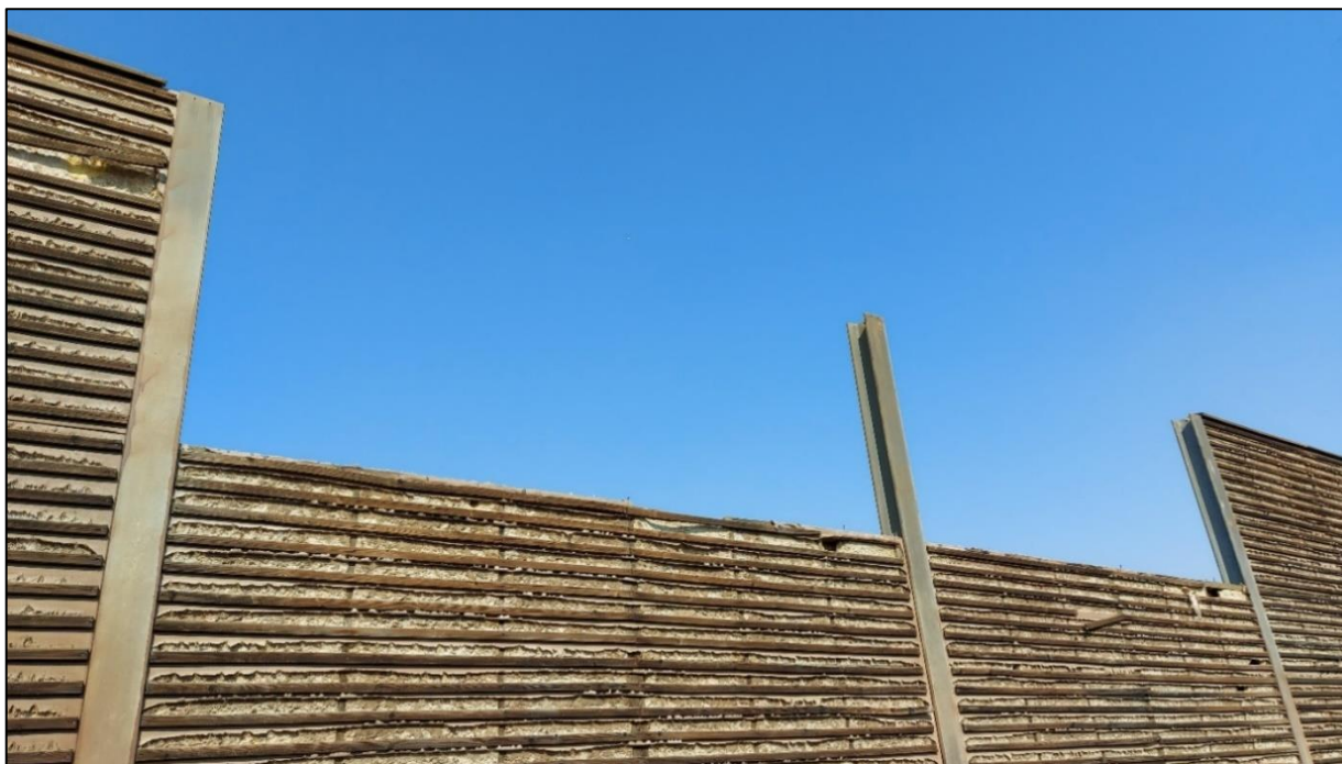
Slika 4. km 259+550.00 – pozicija panela koji nedostaju
