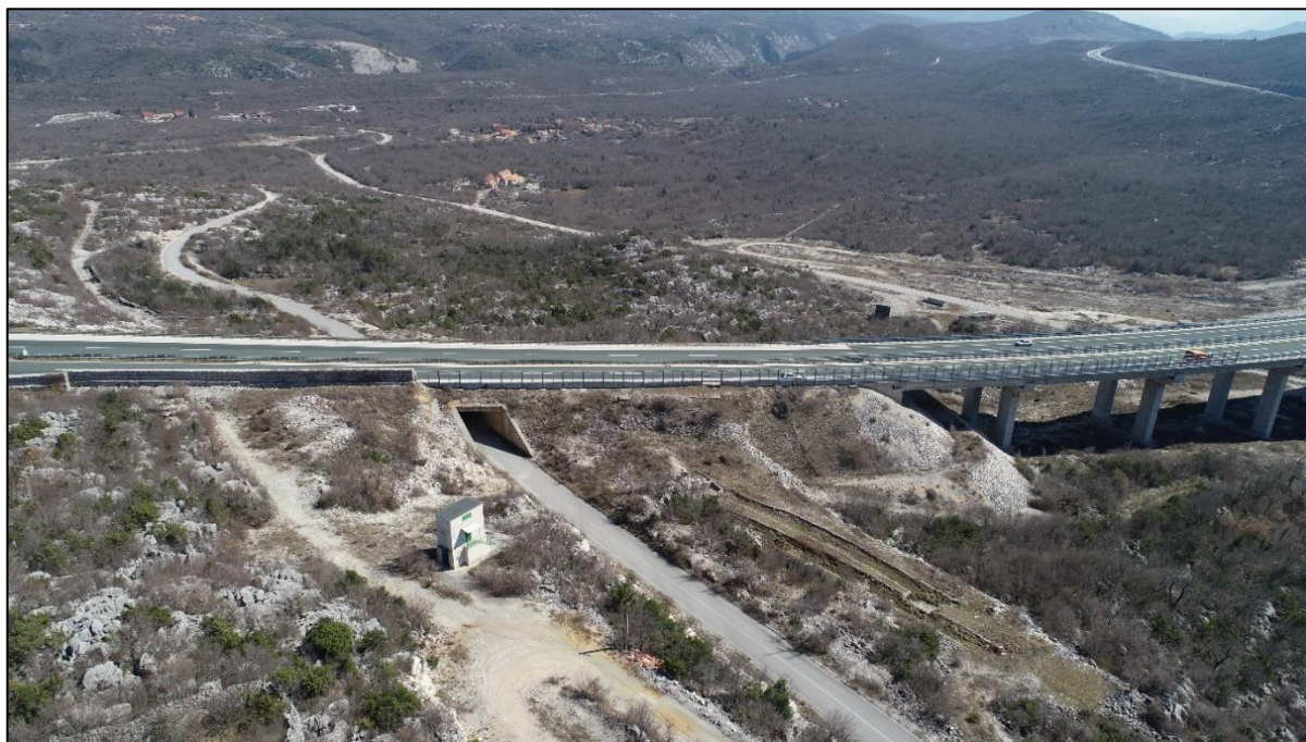
Slika 1. Zid za zaštitu od buke na autocesti A1 - km 397+400.00, vijadukt Srijane
