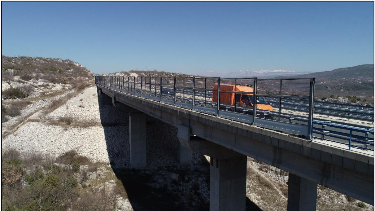
Slika 3. Pogled na dio zida koji se nalazi na vijaduktu Srijane
