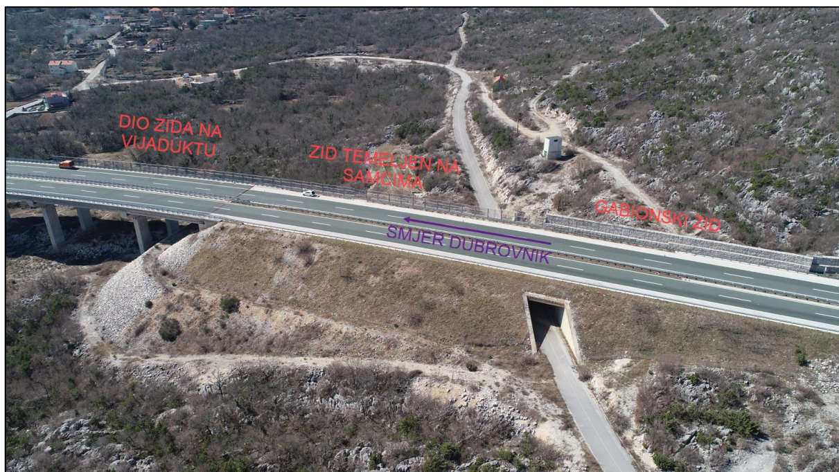
Slika 2. Pogled na lokaciju zida za zaštitu od buke
