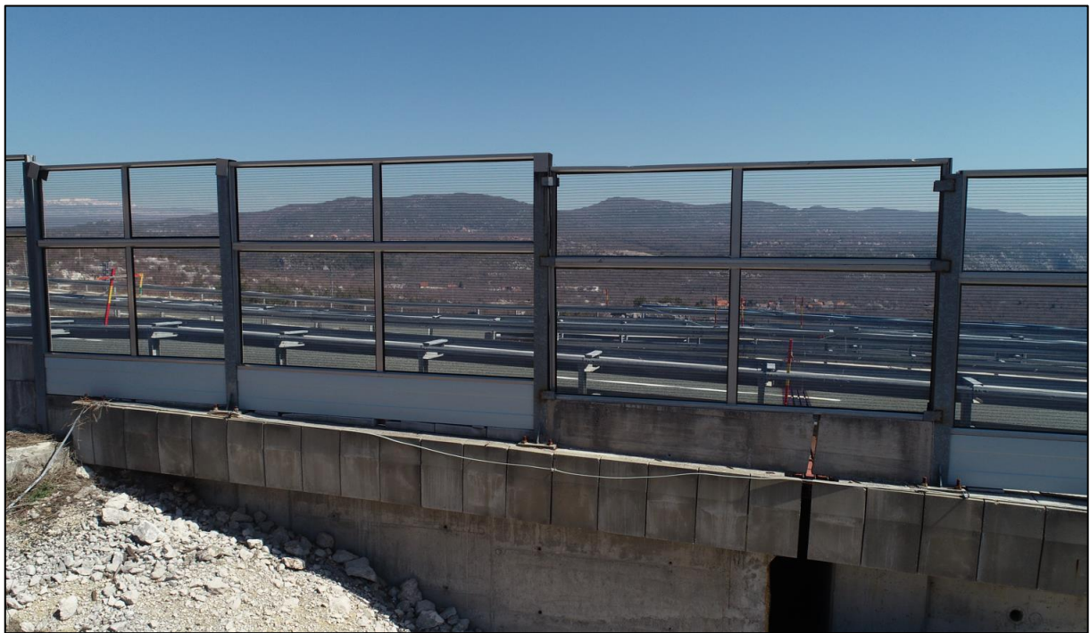
Slika 4. Dio zida s AB gredom preko prijelazne naprave
