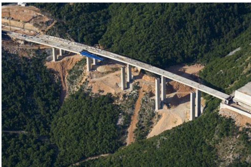
Slika 1.2-1 Pogled vijadukt Kuk za vrijeme izvedbe.
