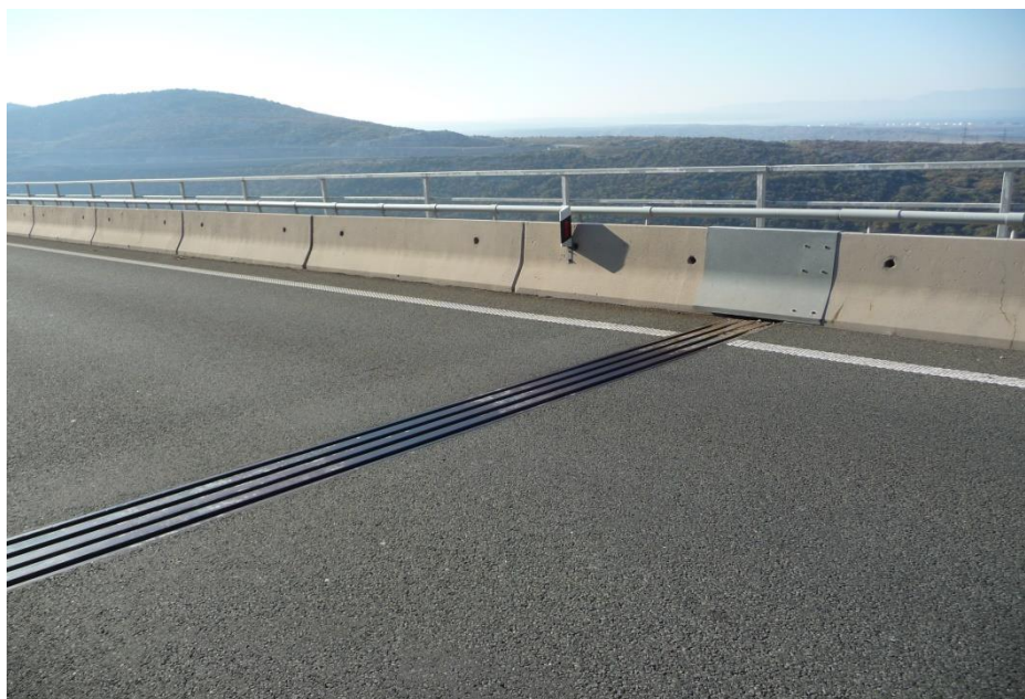
Slika 1.2-2 Pogled na zapadnu prijelaznu napravu (smjer Rijeka) južnog objekta.
