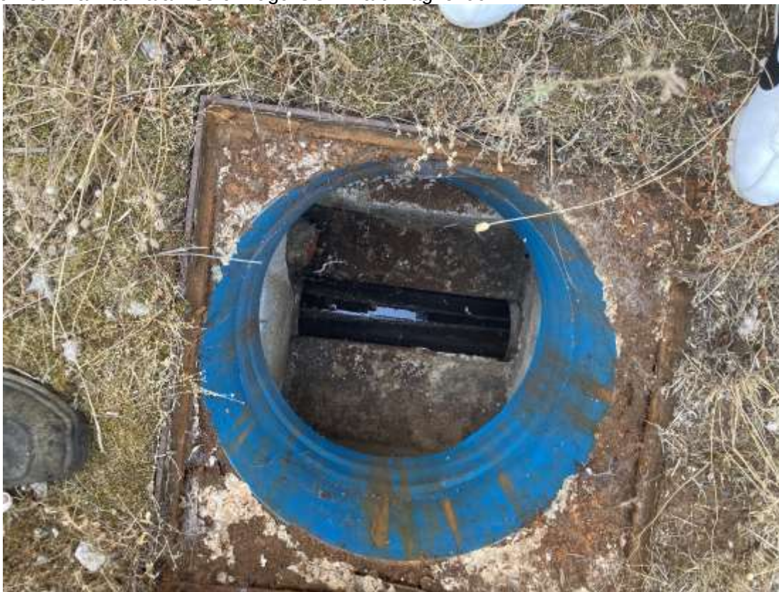
Slika 1. Karakteristično revizijsko okno sanitarne odvodnje RO_3
