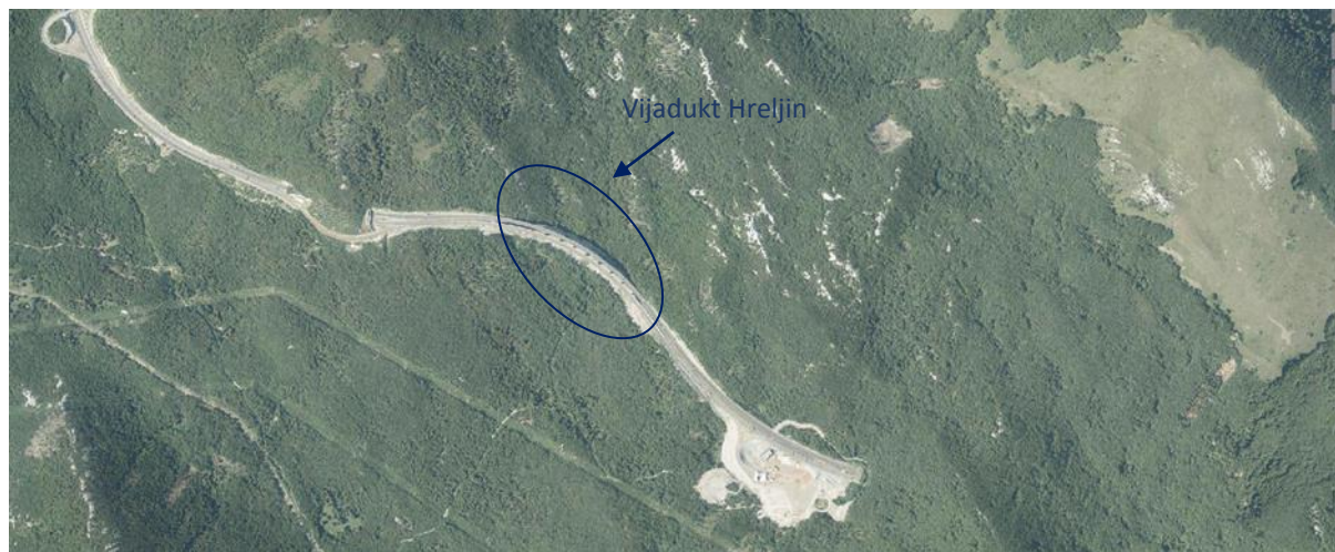
Slika 1_Vijadukt Hreljin – lijevo i desno u km 60+600 autoceste A6, Dionica: Vrata – Oštrovica
