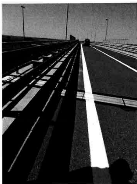
Slika 3_ Pukotine manjeg opsega u južnom zaštitnom traku i otvaranje reške između asfalta kolnika i rubnjaka staze.
