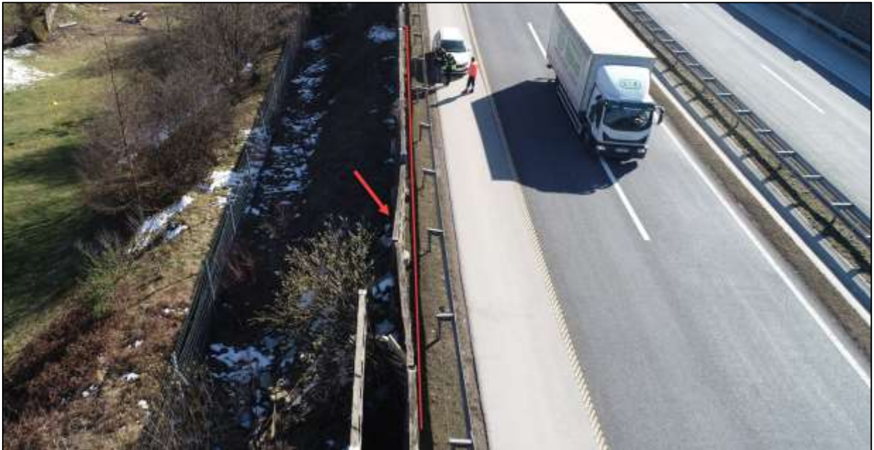
Slika 3. Paneli su van ravnine zida za zaštitu od buke
