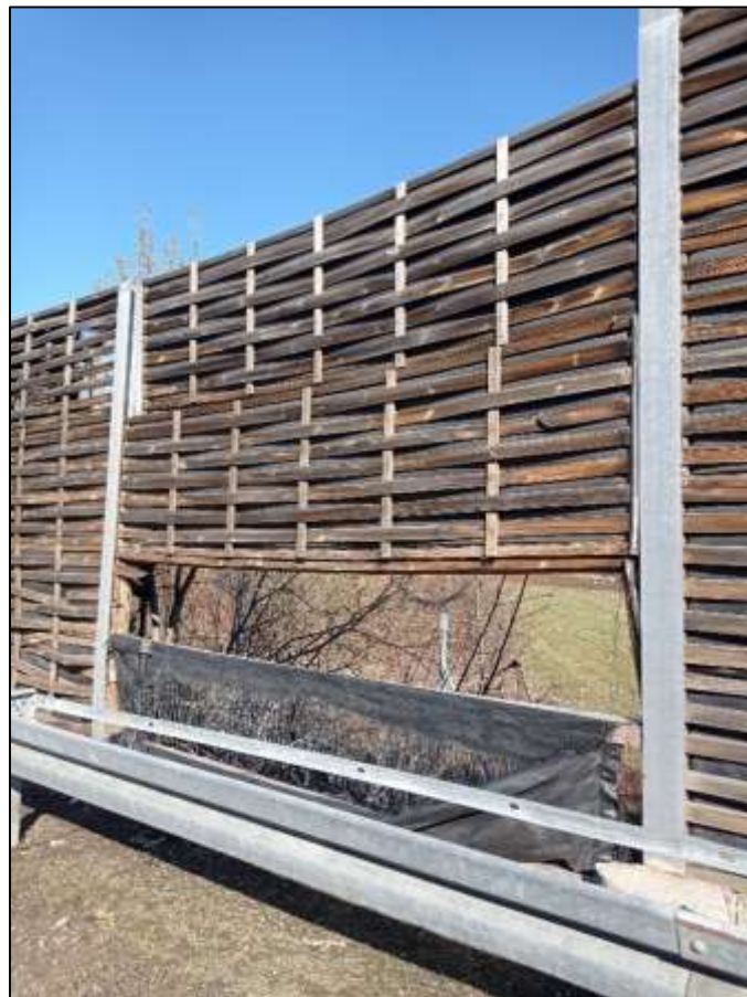
Slika 4. Polje zida za zaštitu od buke na mjestu udara vozila
