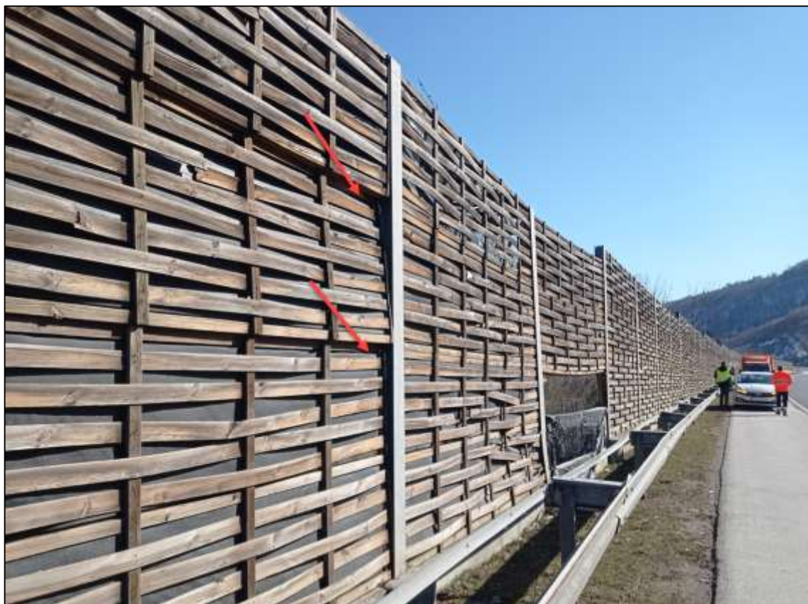
Slika 7. Paneli koji su izvan HEA stupa
