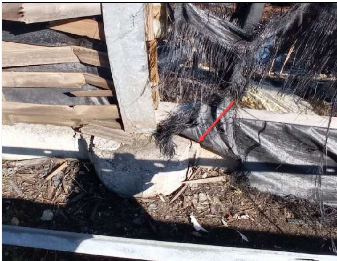
Slika 9. Spoj naglavne grede i glave pilota
