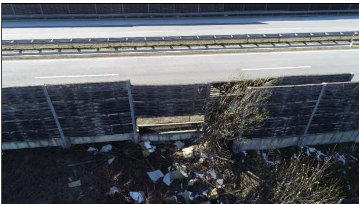
Slika 10. Pogled na stražnju stranu zida za zaštitu od buke
