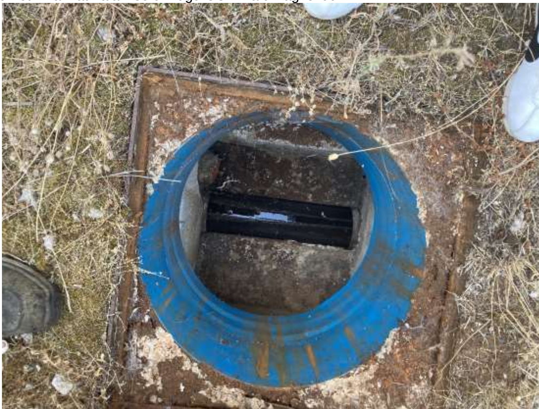
Slika 1. Karakteristično revizijsko okno sanitarne odvodnje RO_3
