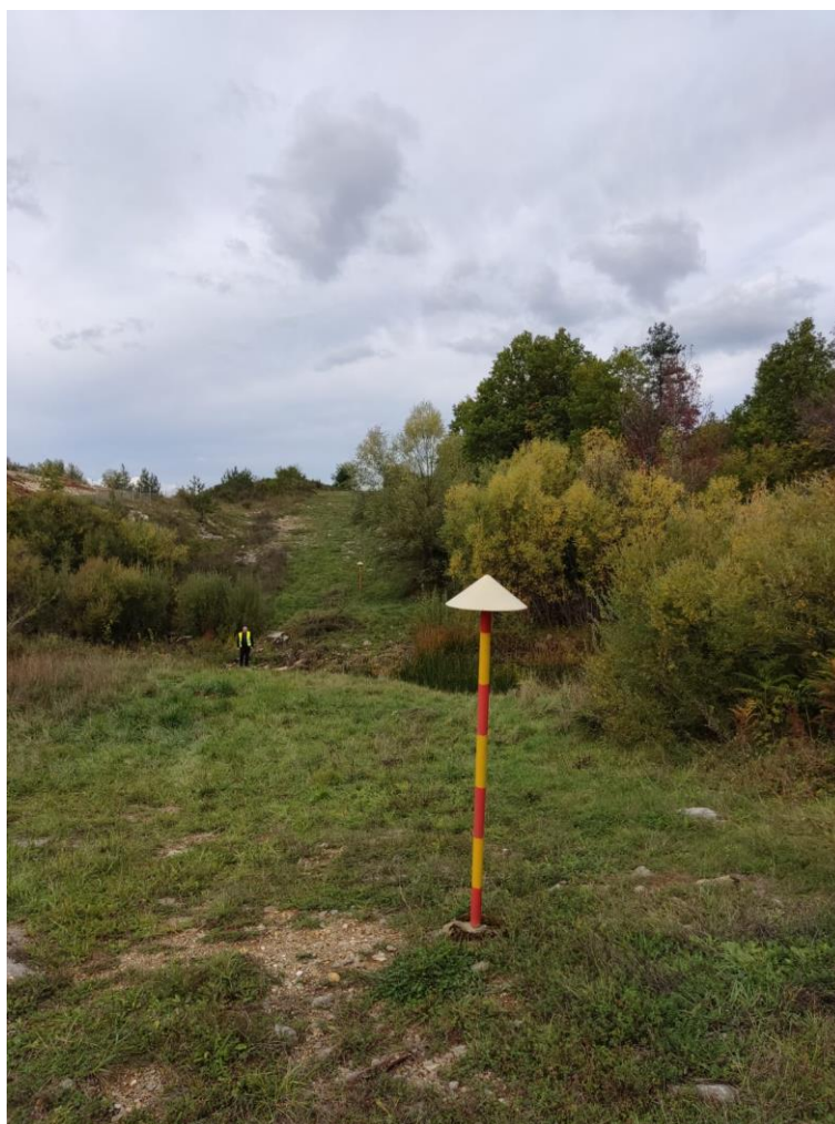
Slika 4. Mjesto križanja magistralnog plinovoda i korita vodotoka
