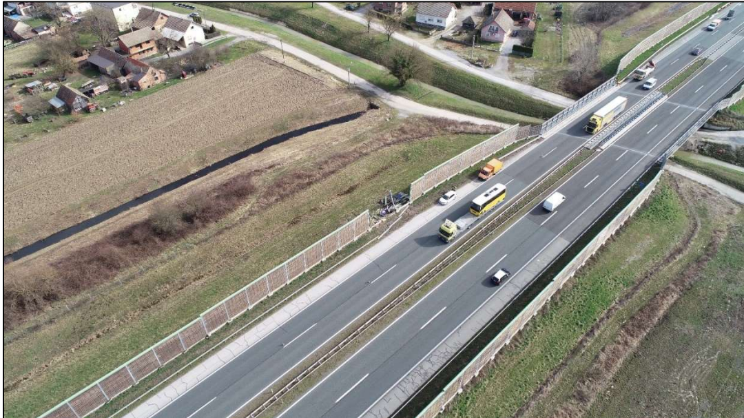
Slika 1. Zid za zaštitu od buke na autocesti A3 prije čvora Kutina – lokacija 03
