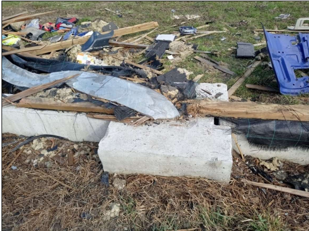
Slika 5. km 105+205.00 - oštećenje čašice i naglavne grede na poziciji HEA profila oznake 3 (vidi Slika 2.)
