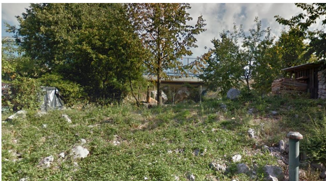
Slika 1.2-4 Pogled na objekt s gradske ulice.
