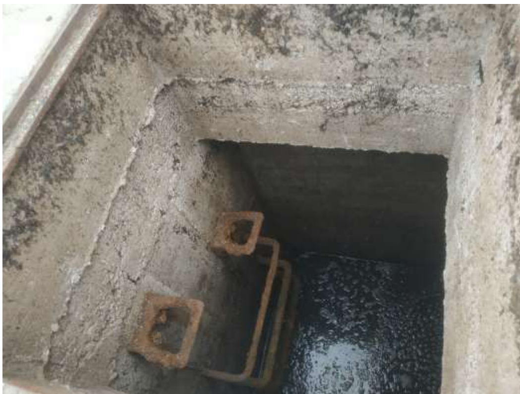
Slika 2: Postojeće stanje sabirne jame
