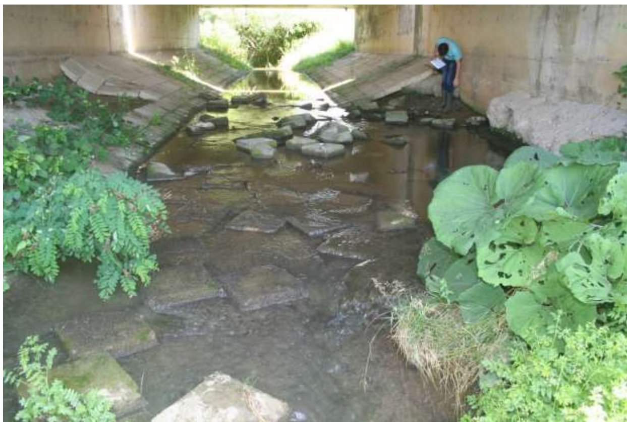
Slika 2 Fotodokumentacija oštećene obloge korita vodotoka (dana 17.06.2021.)
