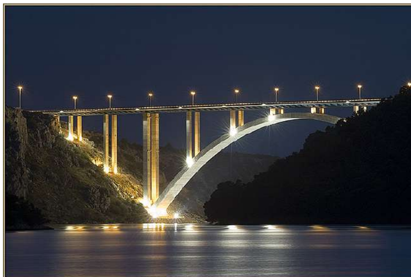
Most Krka kao primjer mosta na kojem je postavljena i rasvjeta kolnika i rasvjeta konstrukcije
