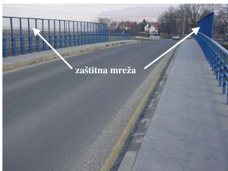
Pogled na površinu kolnika na nadvožnjaku preko autoceste na kojem je postavljena zaštitna mreža
