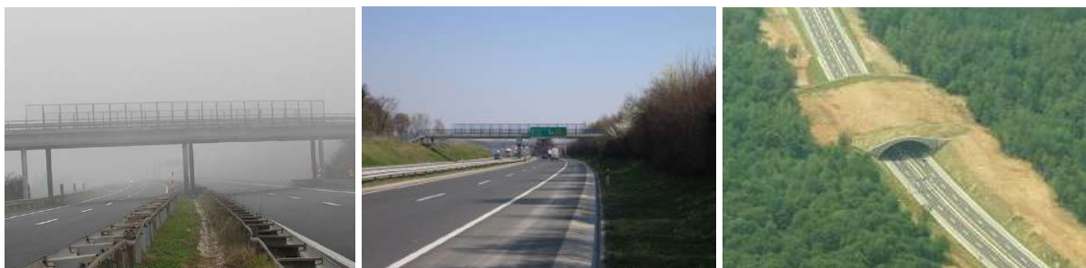
Mostovi preko trase autoceste: cestovni nadvožnjak; pješački nathodnik; prijelaz za životinje
