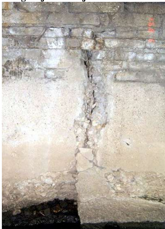
Diferencijalno slijeganje upornjaka.
