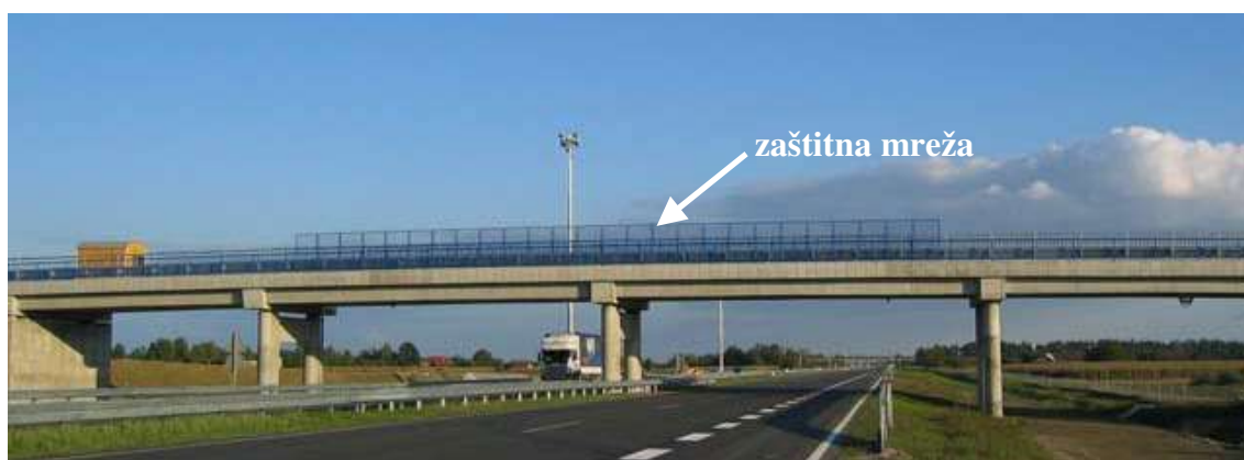
Pogled na nadvožnjak u čvoru Križ, na kojem je postavljena zaštitna mreža
