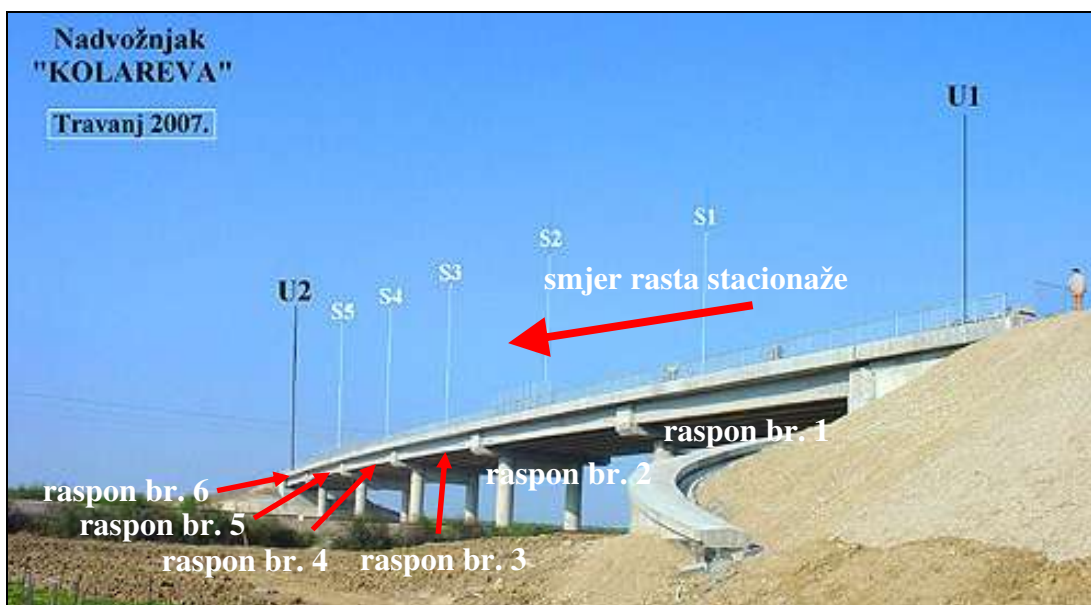
Određivanje rednog broja raspona kod mostova u trasi
