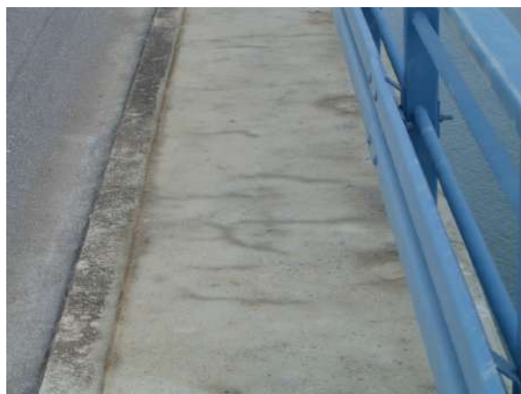
poprečne pukotine
