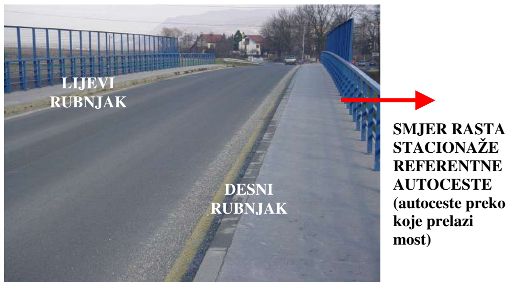
Pogled na površinu kolnika mosta preko trase autoceste i definicija smjera lijevo i desno
