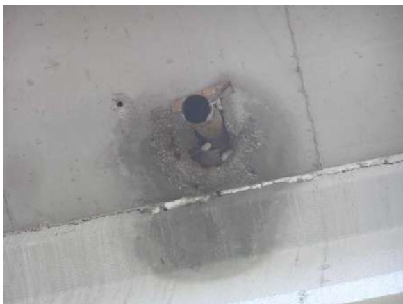
procurivanje uz cijev odvodnje
