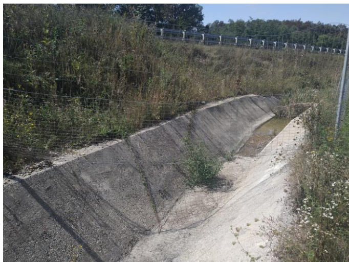
Prijelaz ZŽO preko kanala u km 27+100 lijevo
