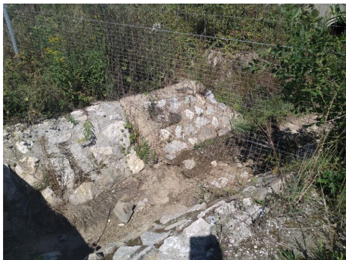
prijelaz ZŽO preko kanala u km 27+500 desno
