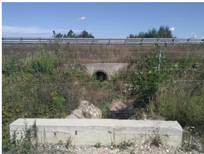
prijelaz ZŽO preko kanala u km 27+500 desno
