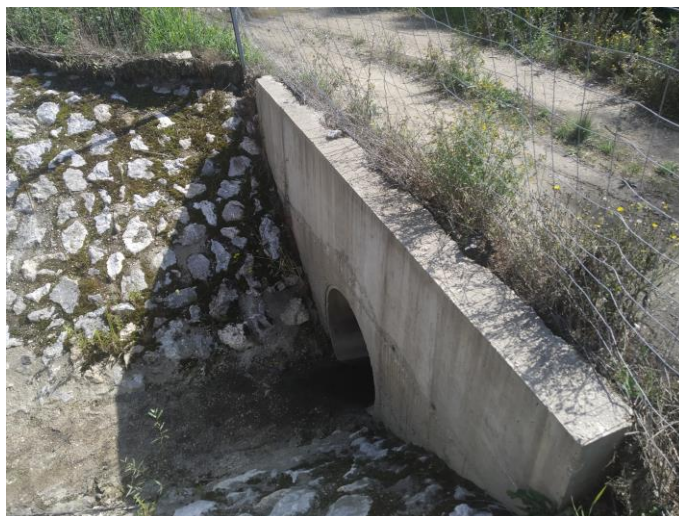
Prijelaz ŽŽO preko kanala u km 24+400 desno
