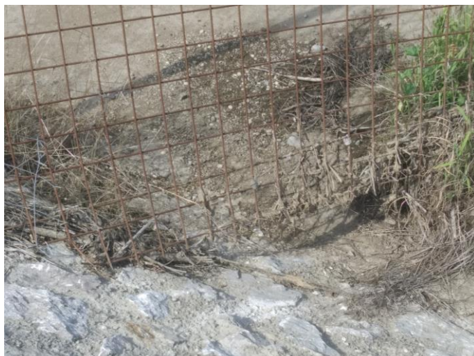
Postojeći otvor u ZŽO u km 24+600 desno
