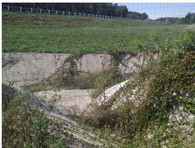
Prijelaz ZŽO preko kanala u km 27+250 lijevo
