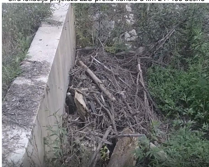
Zatrpan ulaz u cijevni betonski propust
