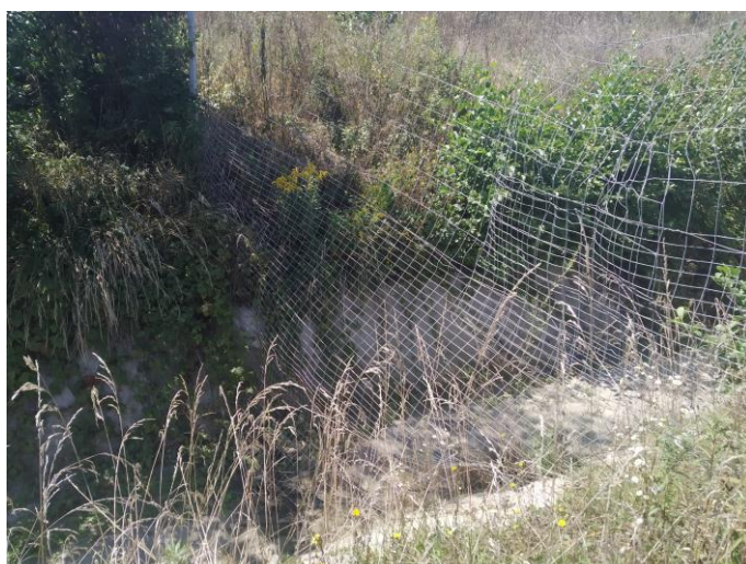
Prijelaz ZŽO preko kanala u km 27+500 lijevo
