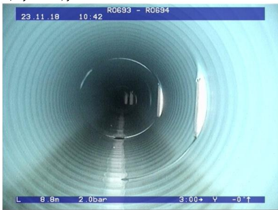
Slika 1 - Kolizija cjevovoda i stupića ograde
