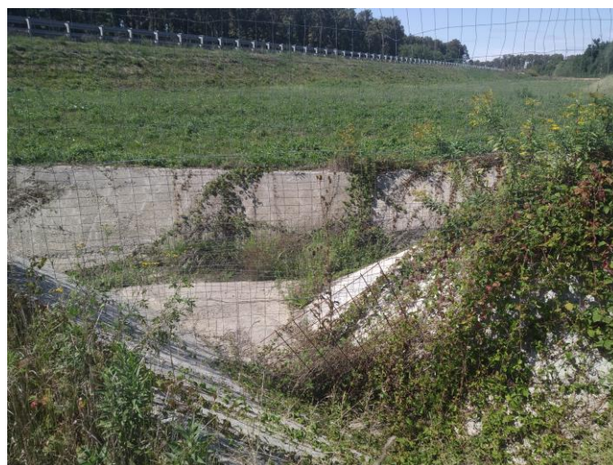
Prijelaz ZŽO preko kanala u km 27+250 lijevo
