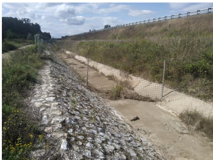
Prijelaz ZŽO preko kanala u km 24+600 desno
