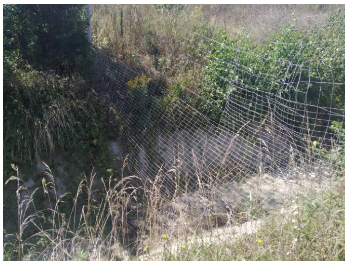
Prijelaz ZŽO preko kanala u km 27+500 lijevo
