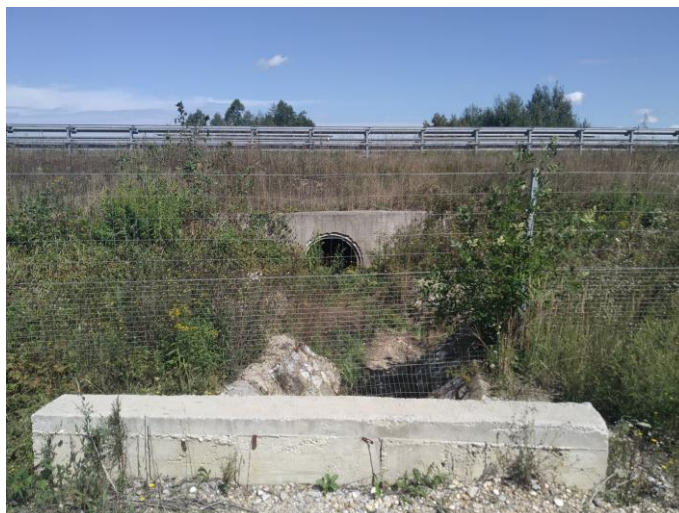
prijelaz ZŽO preko kanala u km 27+500 desno
