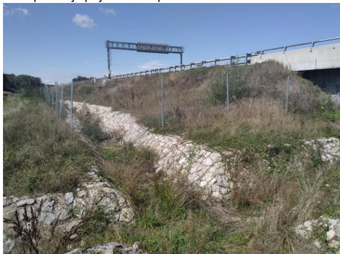
Šire područje prijelaza ZŽO preko kanala u km 28+500 desno
