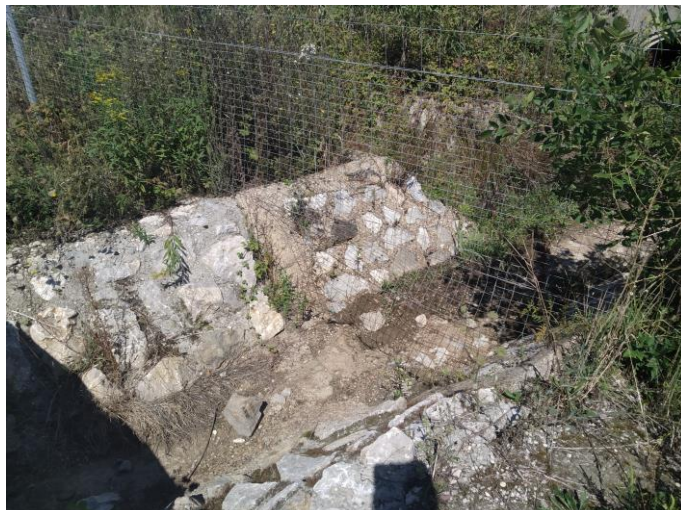
prijelaz ZŽO preko kanala u km 27+500 desno
