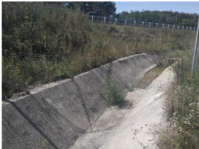
Prijelaz ZŽO preko kanala u km 27+100 lijevo
