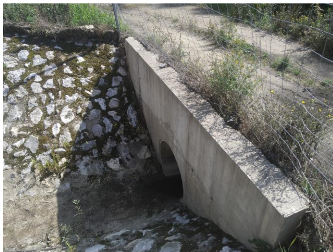
Prijelaz ŽŽO preko kanala u km 24+400 desno
