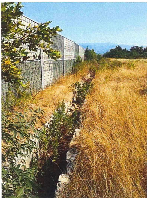
Slika 2 Fotografija otvorenog obodnog kanala
