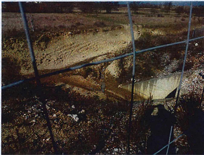
Nizvodna strana propusta; s lijeve strane vidljiv je 'trag' dolaska vode iz izvora te 'priručno iskopan' jarak prema desno koji zadržava vode koje se procjeđuju dalje desno (nizvodno, u smjeru pada terena - prema sjeveru tj desno na slici)
