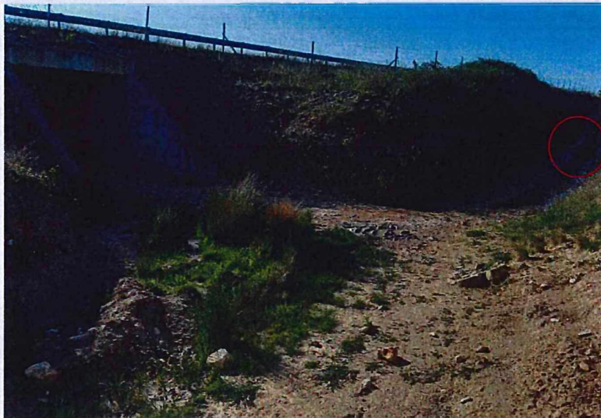
Nizvodna strana propusta s povremenim izvorom (zaokruženo)
