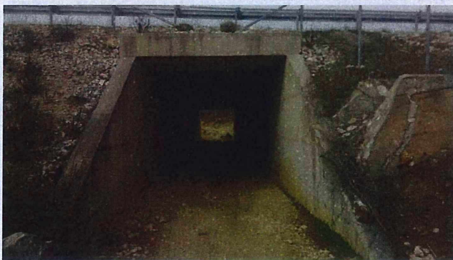
Uzvodna strana propusta, betonski kanal sa završetkom na krilu prolaza
