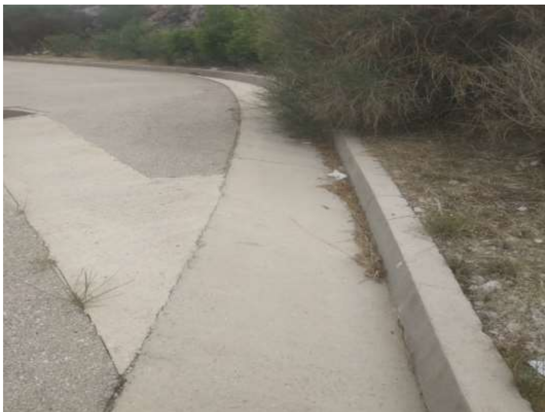
Slika 4: Sanacija asfaltnog zastora betonom
