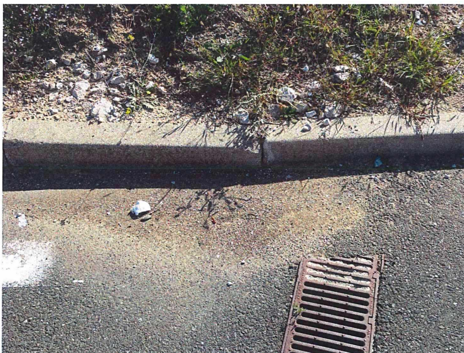
Uzvodni kraj rešetke, vidljivo je da rešetka ne dolazi do ruba rigola te se za vrijeme oborina stvara 'lokva' (vidljivo iz stvorenog nanosa)
