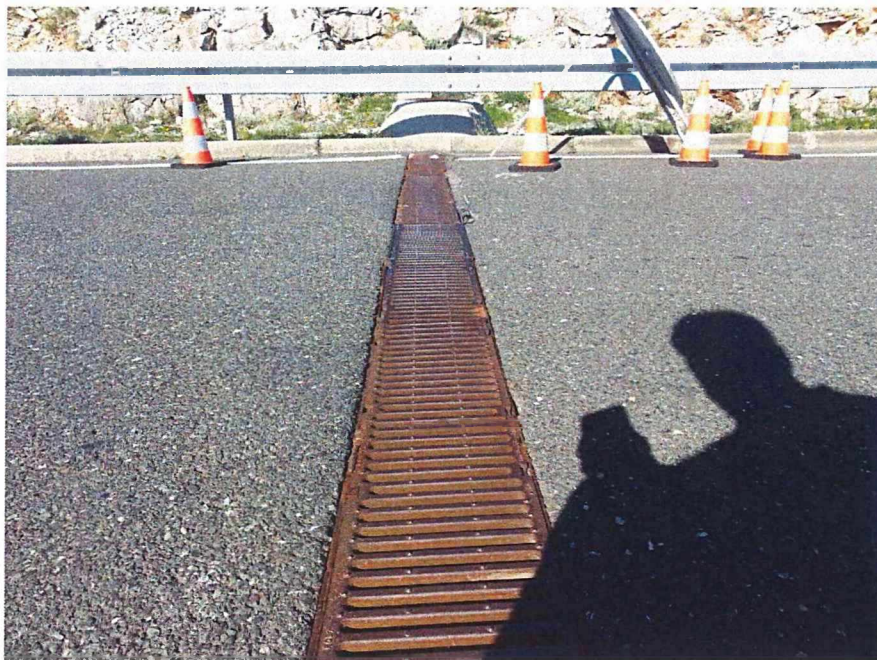
Linijnska rešetka na rubnoj (izlazna ENC) traci (uočava se 'uleknuće' cijele rešetke)
