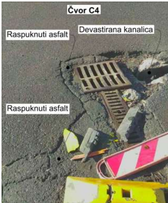
Slika 16: Čvor C4 – Oštećenja asfalta, linijskih kanalica i slivnika
