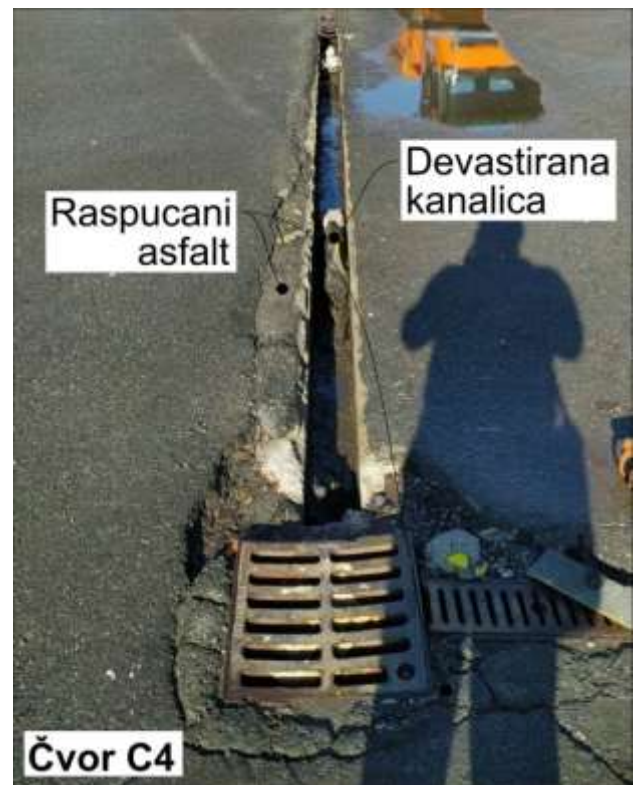
Slika 16: Čvor C4 – Oštećenja asfalta, linijskih kanalica i slivnika
