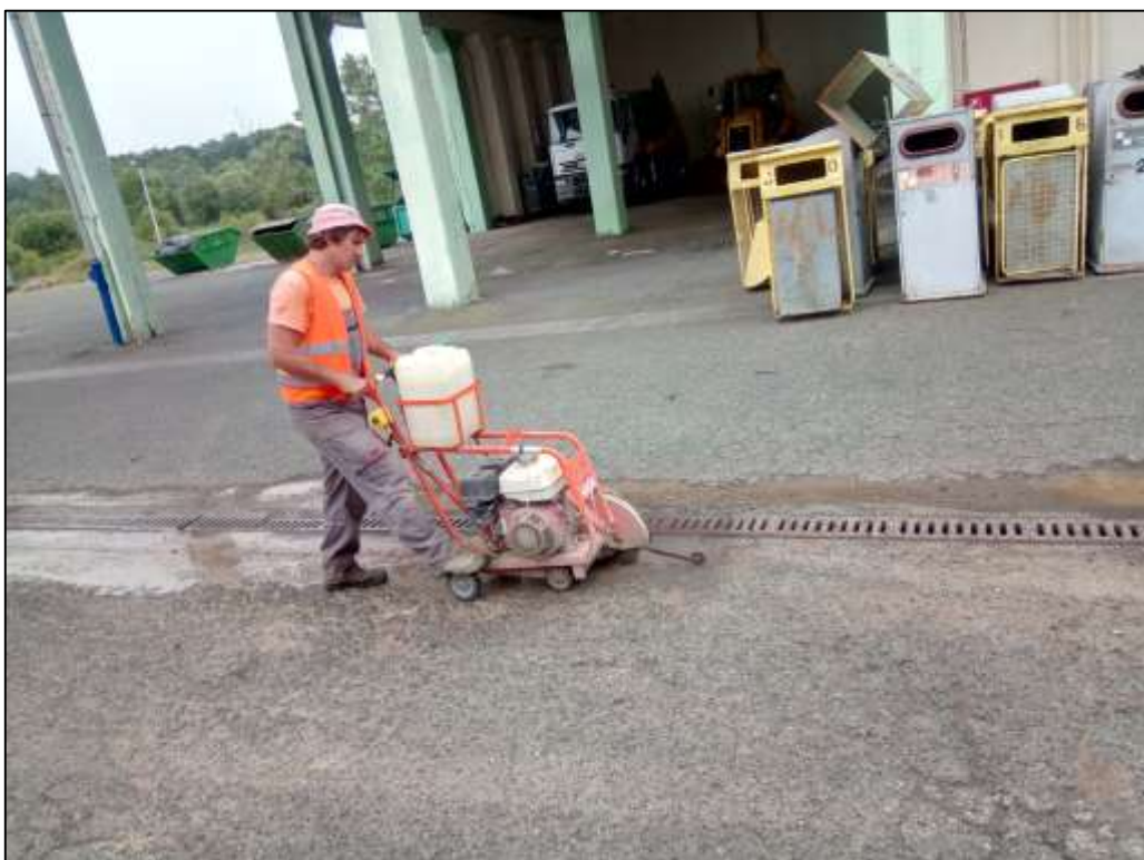
Slika 19: Strojno rezanje asfalta
