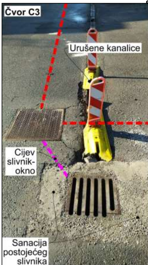
Slika 15: Čvor C3 – Privremeno sanirani slivnik, urušene i uklonjene kanalice
