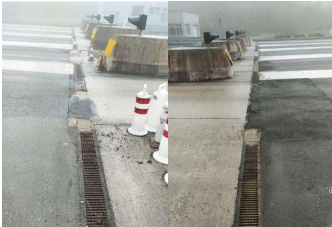
Slika 2: Linijske kanalice – sjeverna i južna stana naplatne postaje
