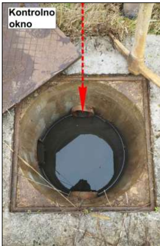
Slika 5: Unutrašnjost kontrolnog okna
