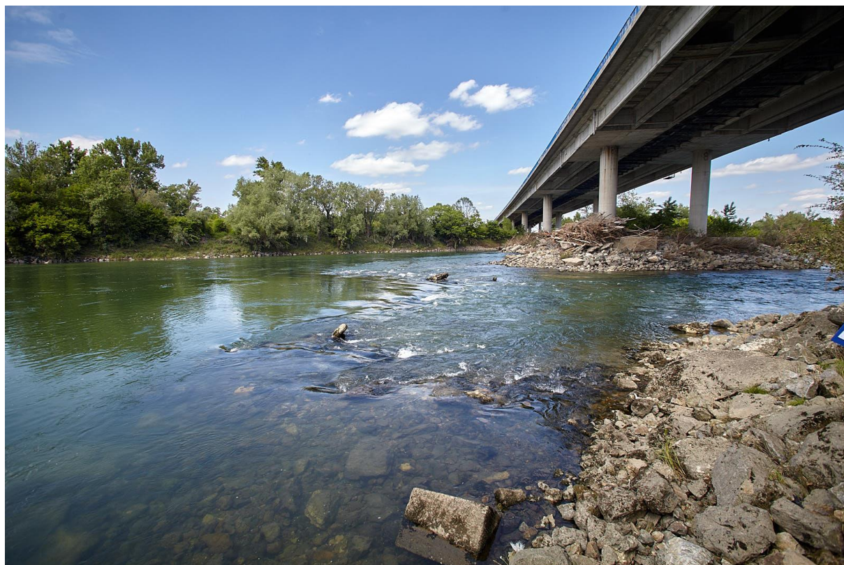
Slika 4 Prag uzvodno od mosta
