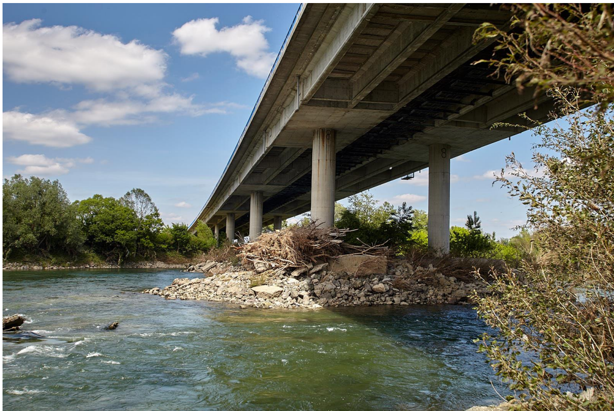
Slika 3 Naplavine na stuištu S15
