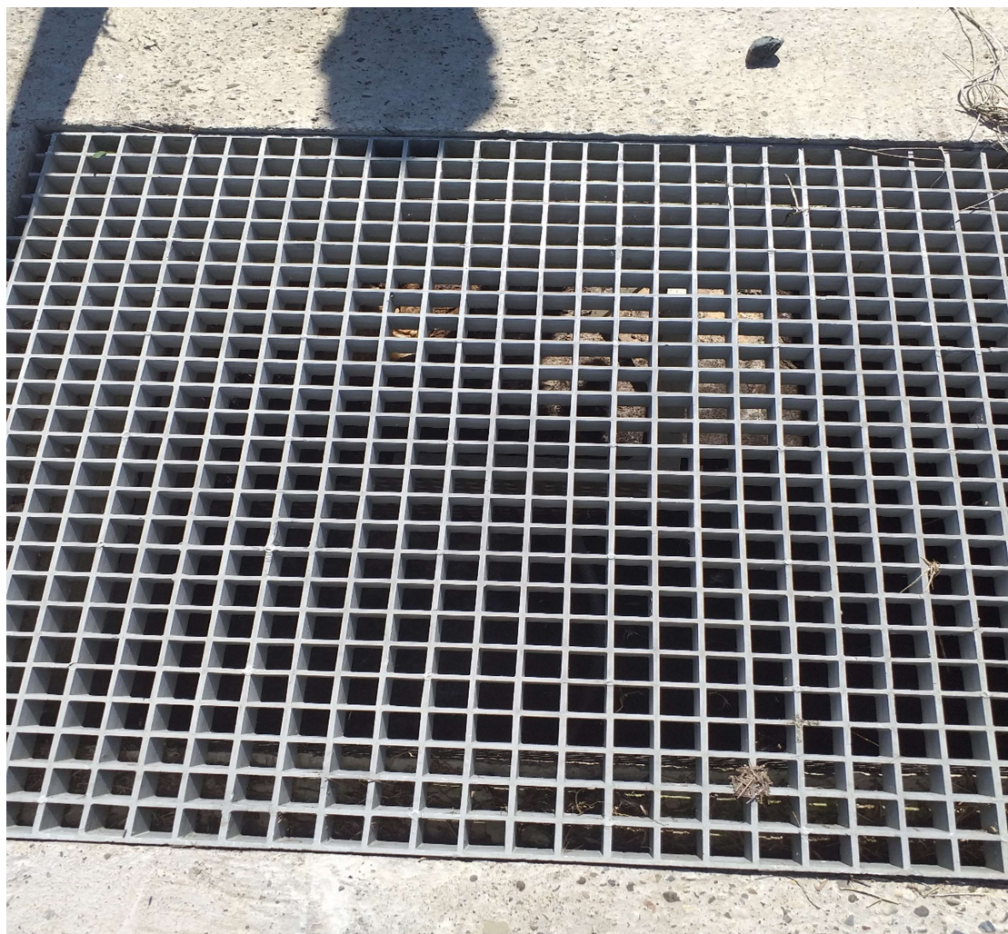
Slika zaštitne rešetke ulaznog okna
