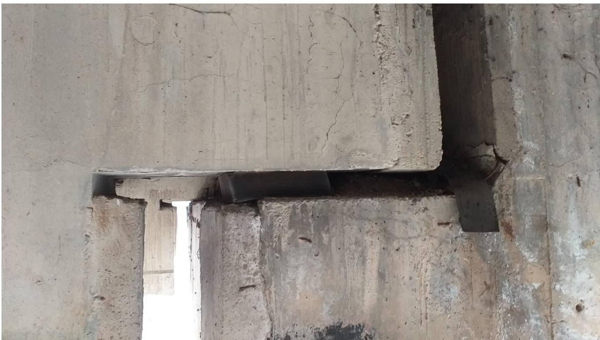
ISTOČNI MOST - stol S6 (S18): pomaknut ležaj
