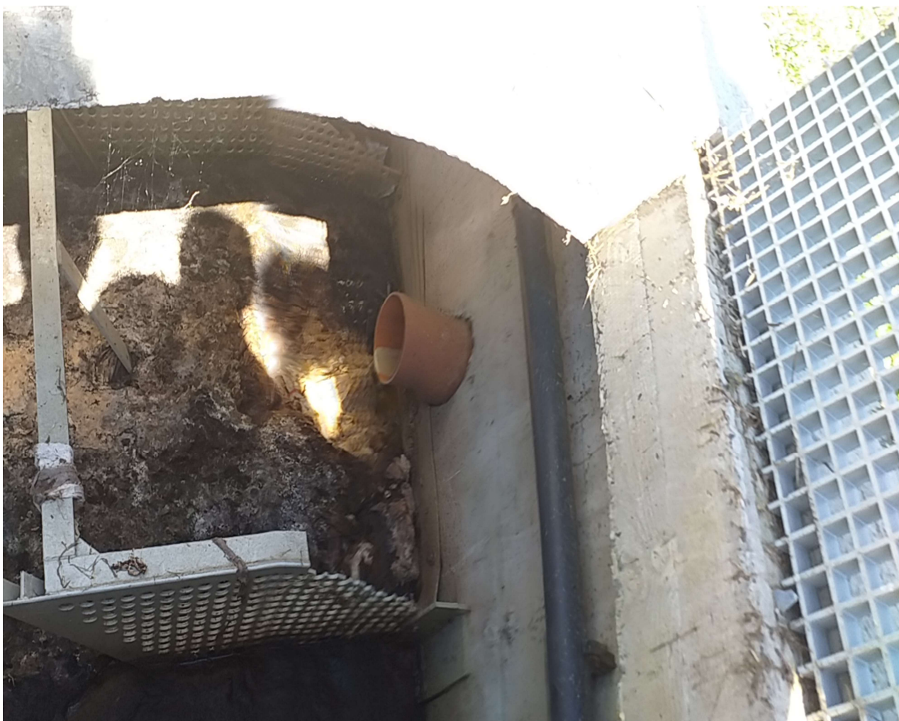
Slika stanja ulazne grube rešetke mehaničkog predtretmana
