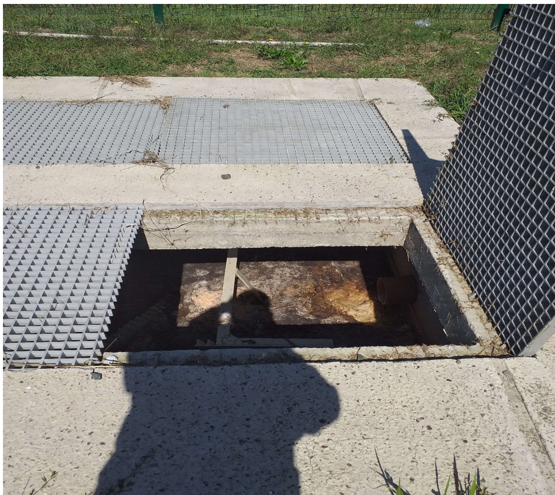
Otvaranje ulaznog okna gdje je smještena gruba rešetka mehaničkog predtretmana
