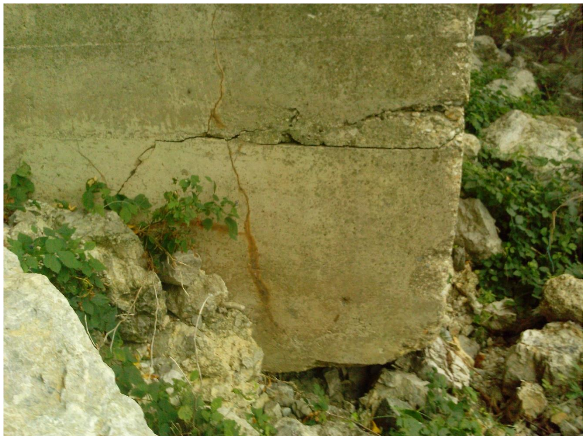
Slika 8 Pukotina naglavne grede temeljne stope stupa S16/1
