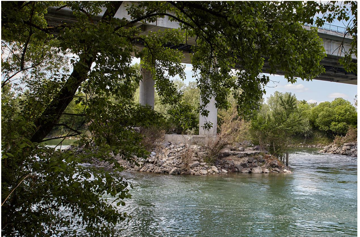
Slika 5 Potkopavanje korita ispod nožice kamenog nabačaja stupišta S15 i njegovo urušavanje u kaverne
