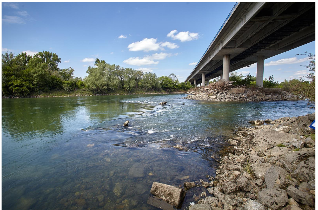
Slika 4 Prag uzvodno od mosta
