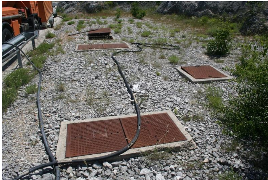
Slika 1 Fotodokumentacija lokacije separatora u stac km 358+050 desno (projekt.stac. km 114+996 D) (dana 27.05.2021.)
