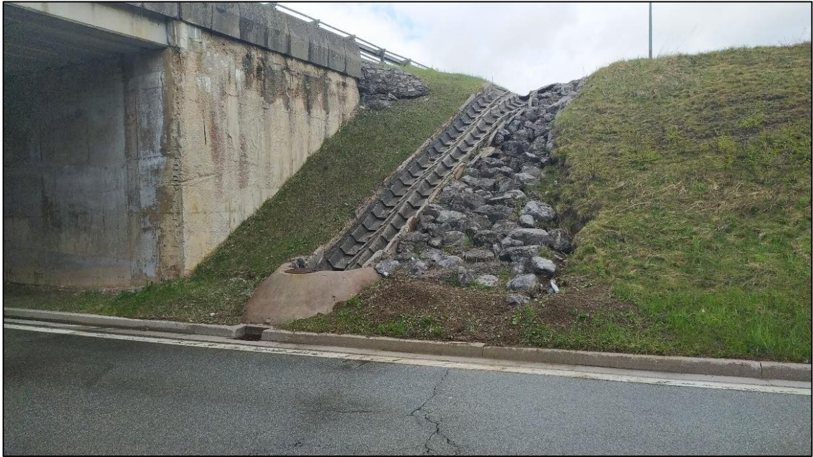
Slika 26: Sjeverna kanalica spojena na RO178/2
