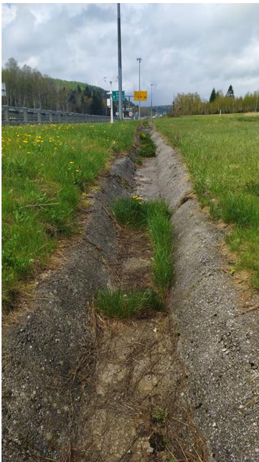
Slika 37: Betonski trapezni kanal
