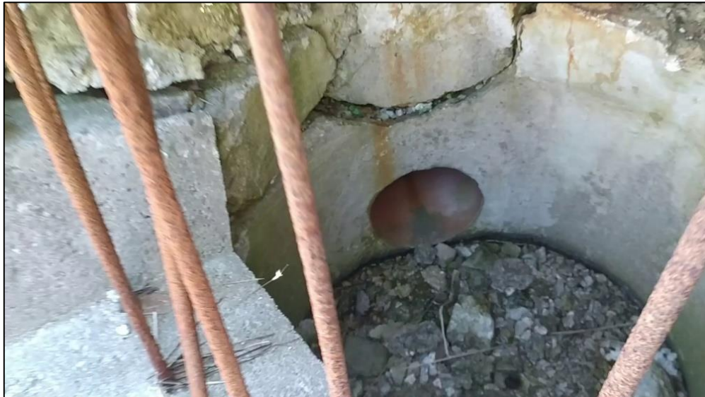
Slika 27: Spoj RO178/2 prema kolektoru RO178 - RO179
