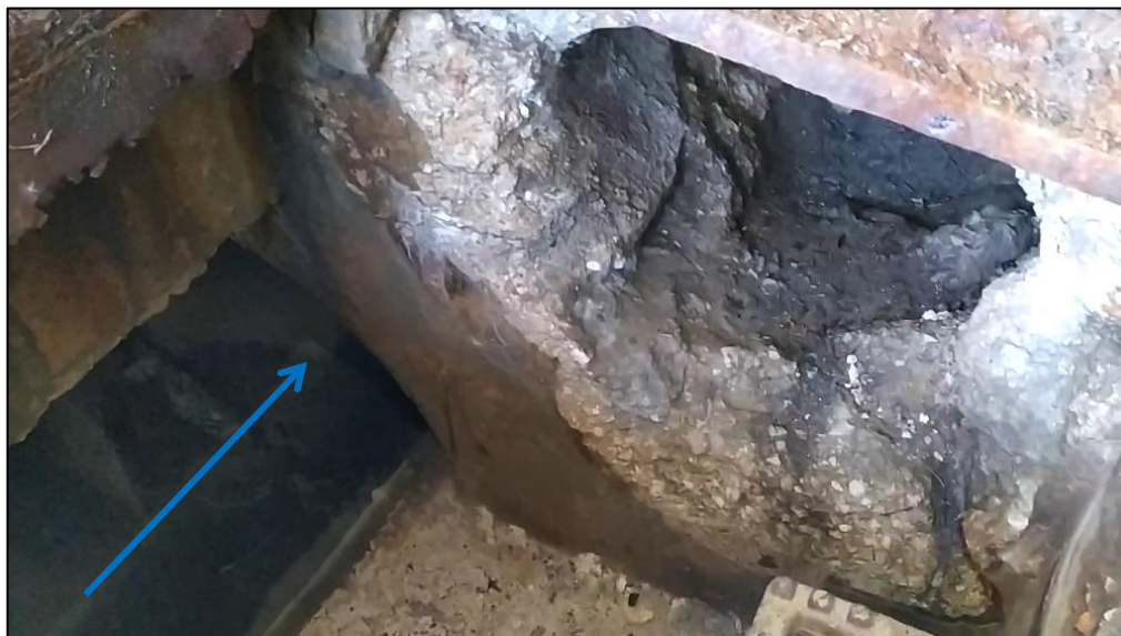
Slika 20: Spoj slivnika SI178/1 na okno RO178
