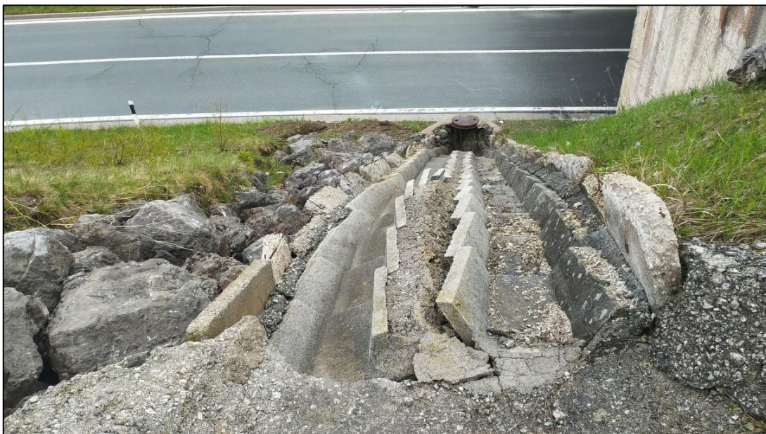
Slika 40: Spoj betonskog trapeznog kanala na okno RO178/2 (kanalice sjever)
