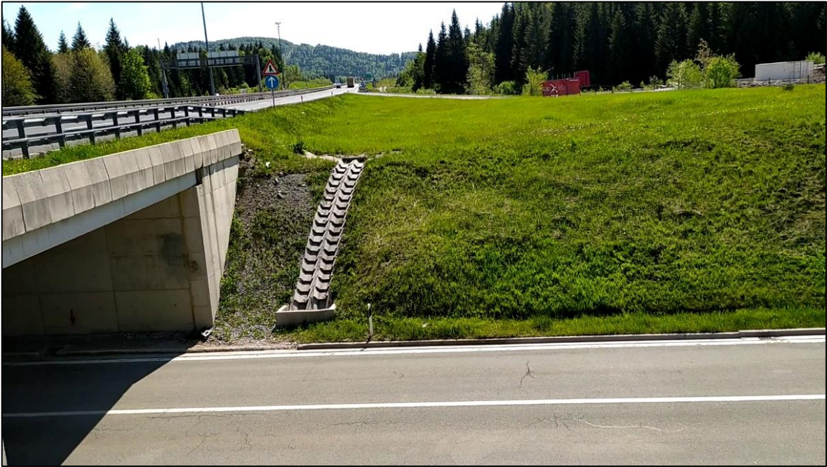
Slika 18: Južna kanalica spojena na SI177/2
