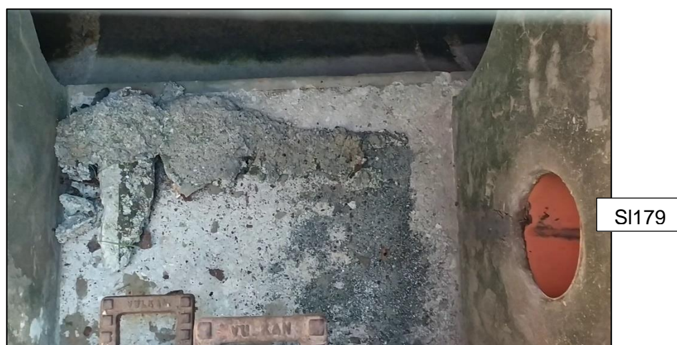
Slika 30: Spoj slivnika SI179 na okno RO179
