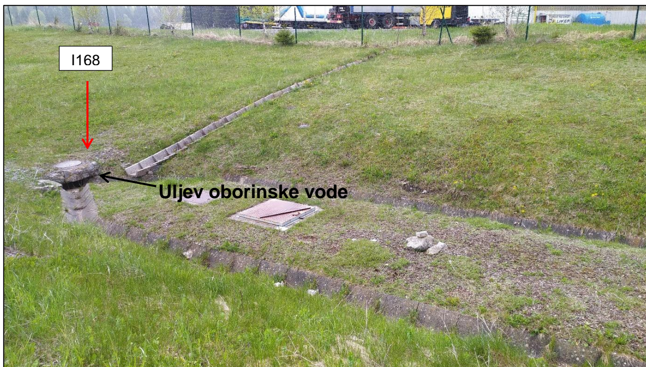
Slika 7: Separator „Ravna Gora“ – I168 – uljev oborinske vode
