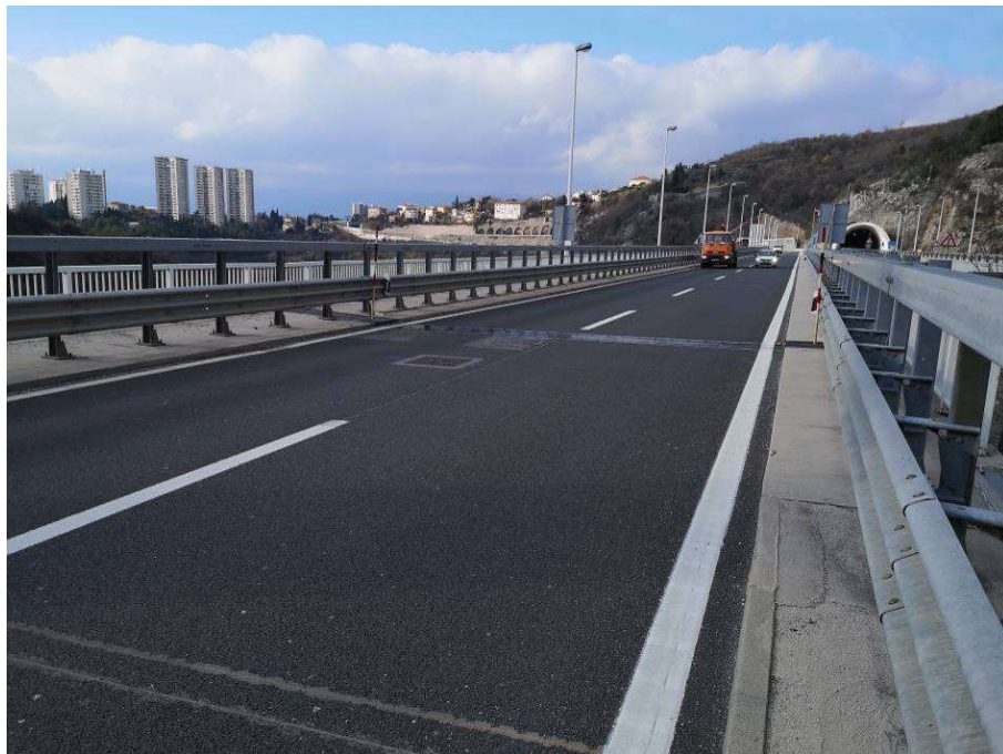
POGLED NA PODVOŽNJAK SA ULICE KOJU PREMOŠĆUJE
