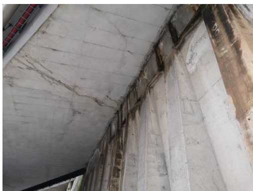
PUKNUĆE SEGMENTA ZAPADNE NAPRAVE
