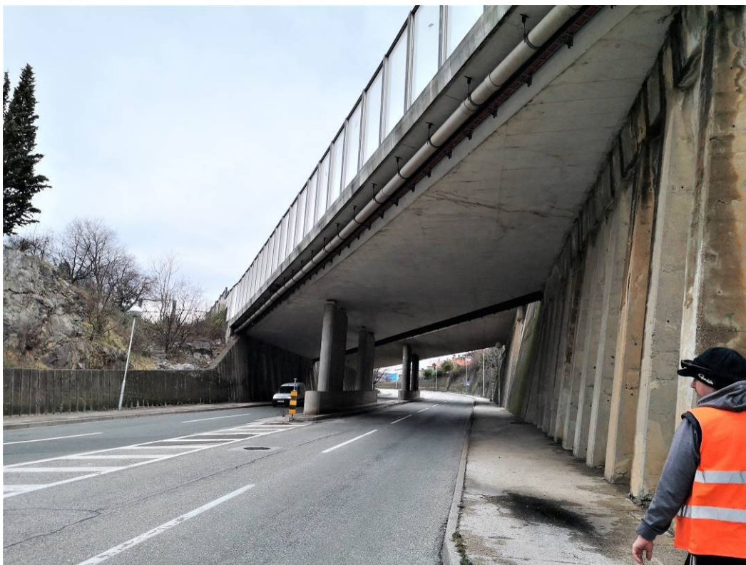
POGLED NA PODVOŽNJAK SA ULICE KOJU PREMOŠĆUJE
