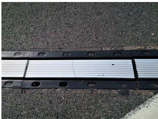
PUKNUĆE SEGMENTA ZAPADNE NAPRAVE
