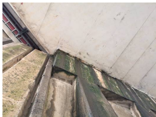
Zapadni upornjak – procunjavanje naprave
