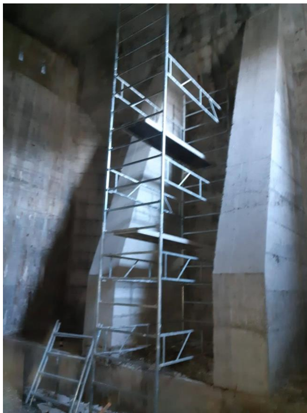
Slika 1.1-1 Upornjačka građevina – pogled
