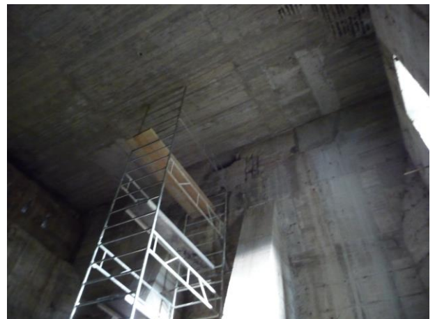
Slika 1.3-10 Odvajanje i otpadanje betona
