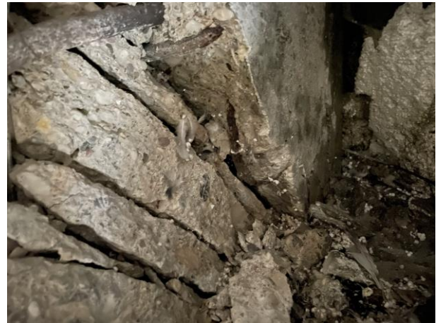
Slika 1.3-10 Odvajanje i otpadanje betona
