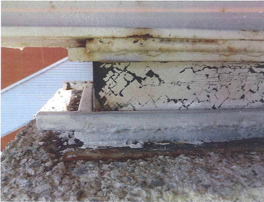
Sl 11. Ležaj na stupu br. 1 : smjer ST. Ležaj ima „okvir“ od kvadratičnih cijevi 20x20 mm na donjem rubu, privaren za donju ležajnu ploču.
