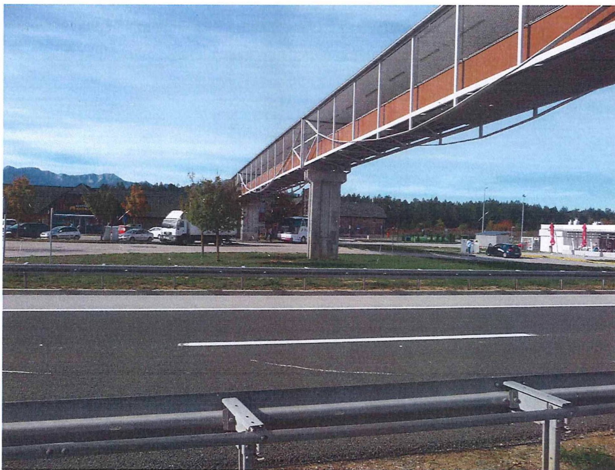
Sl. 1 Pogled na most sa sjevernog stajališta PUO Zir.
