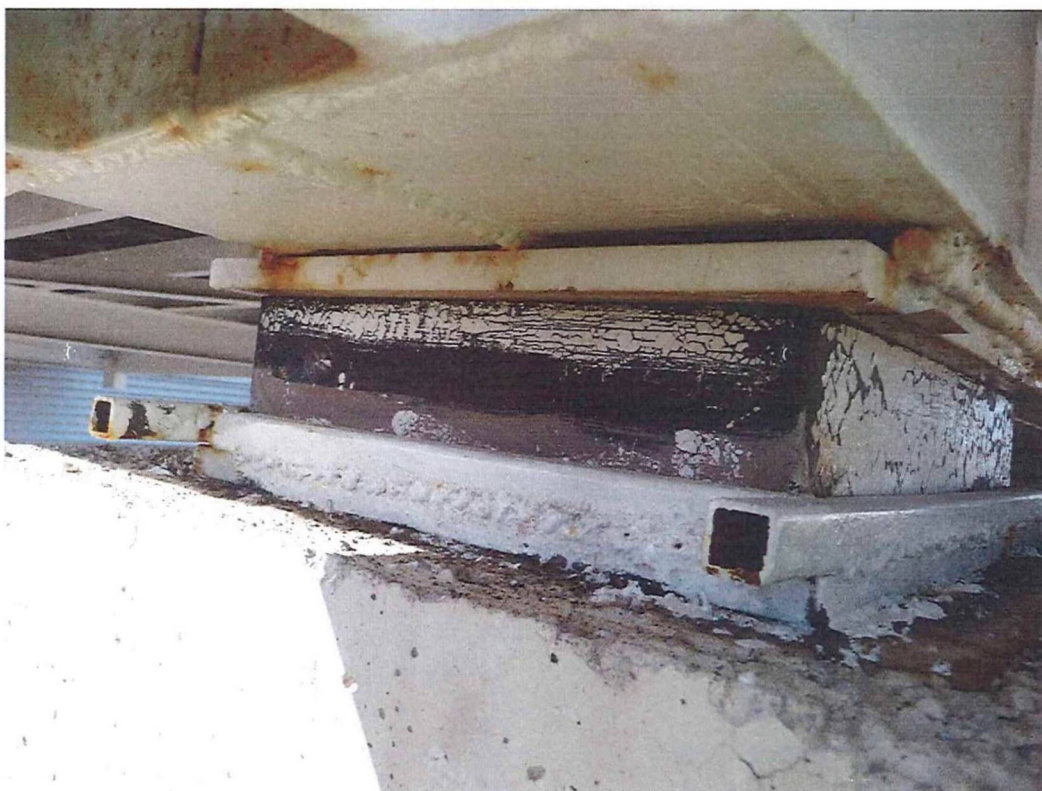
Sl 12 loše priključenje ploče na poprečni nosač - ležaj na stupu br. 1 (ST)
