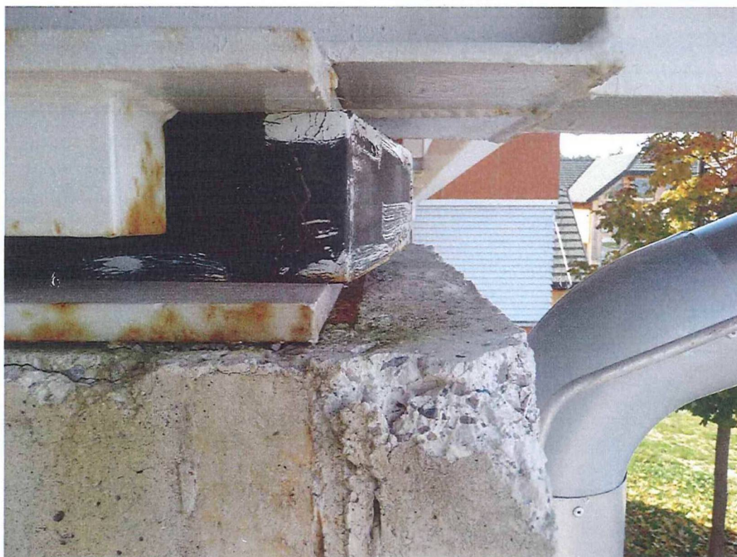
Sl 10.i 11. Ležaj na stupu br. 1 : smjer ZG. Neoprenski jastuk se izmakao za 1-6 cm u odnosu na donju ležajnu ploču, što čini pomak od početnog položaja za cca 12 cm.
