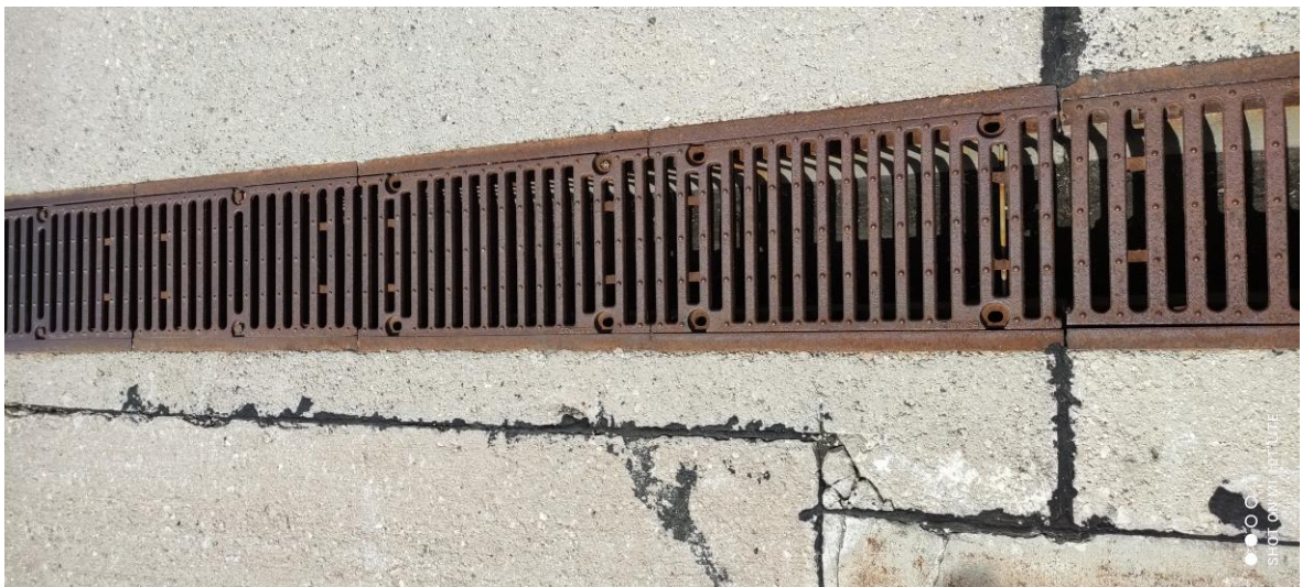
Slika 4. nedostatak pričvrsnih vijaka
