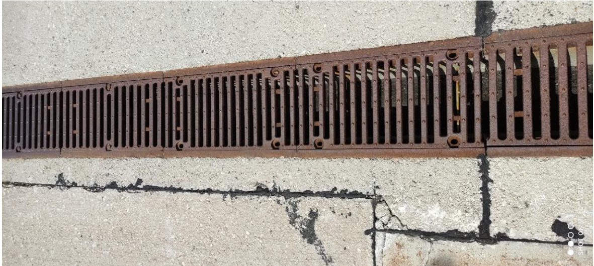
Slika 3. nedostatak pričvrsnih vijaka
