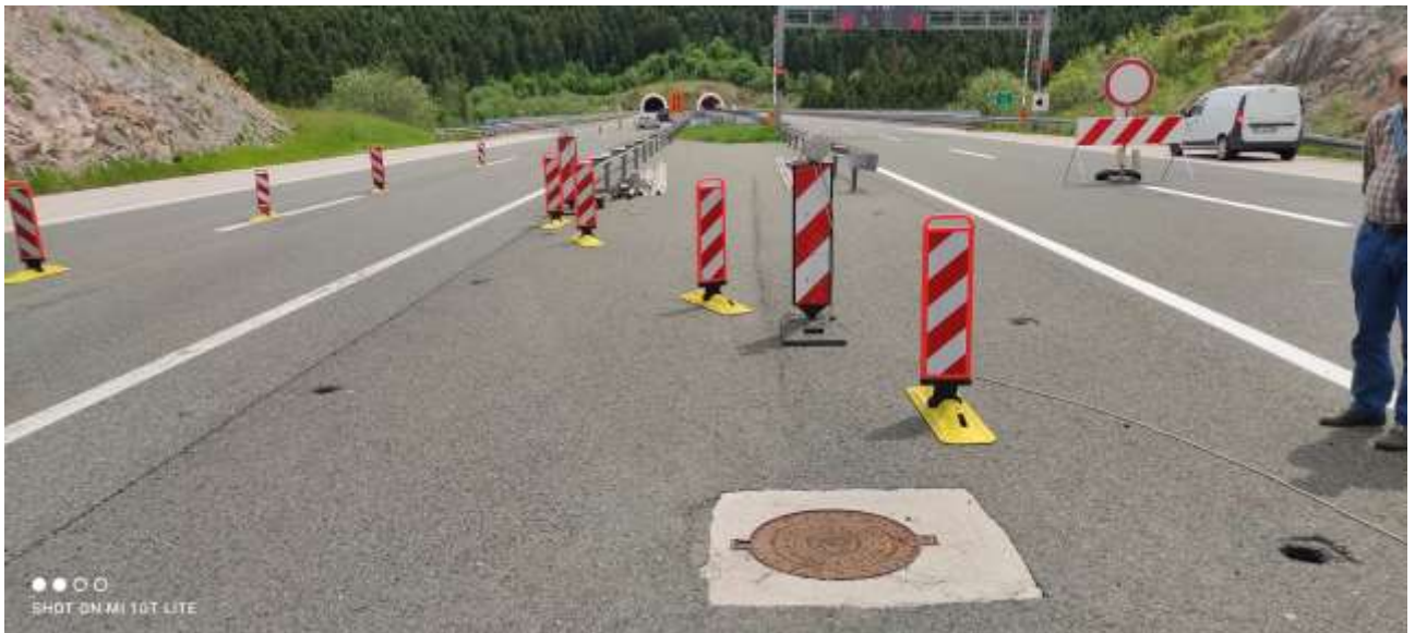
Slika 1. Službeni prolaz – postoj postojeće revizijsko okno Rop1 oborinske kanalizacije
