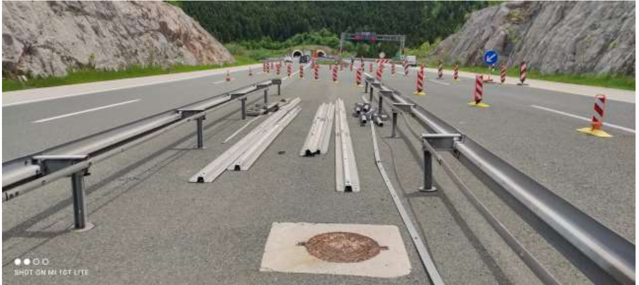
Slika 3. Službeni prolaz – postojeće revizijsko okno Rop2 oborinske kanalizacije
