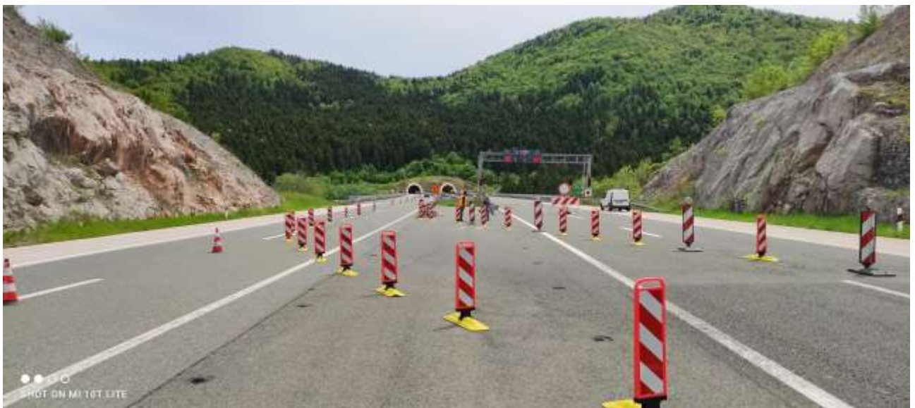
Slika 2. Službeni prolaz – privremena regulacija prometa ( pogled u smjeru tunela Plasina )
