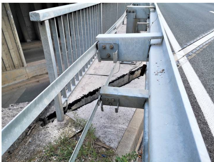
SJEVERNI SERVISNI HODNIK
