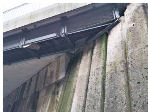
Zapadni upornjak – procurjevanje naprave
