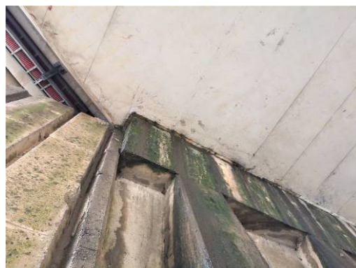
Zapadni upornjak – procurjevanje naprave
