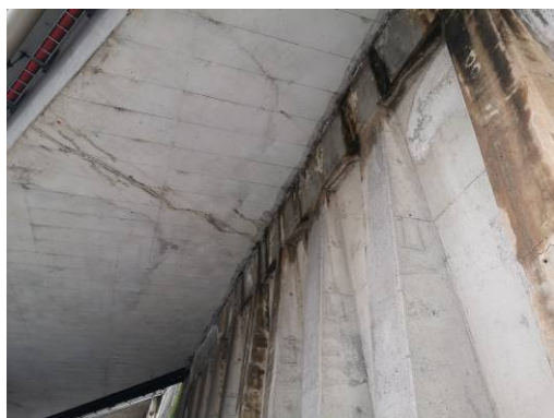
PUKNUĆE SEGMENTA ZAPADNE NAPRAVE
