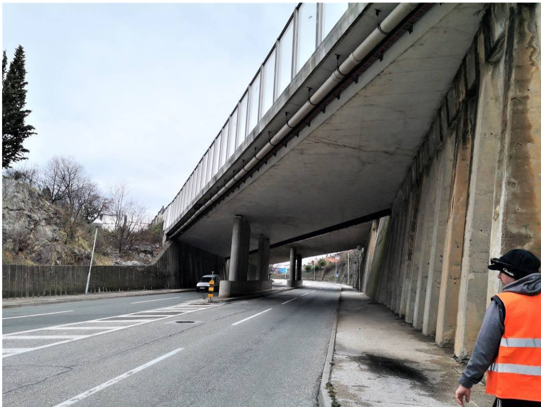
POGLED NA PODVOŽNJAK SA ULICE KOJU PREMOŠĆUJE
