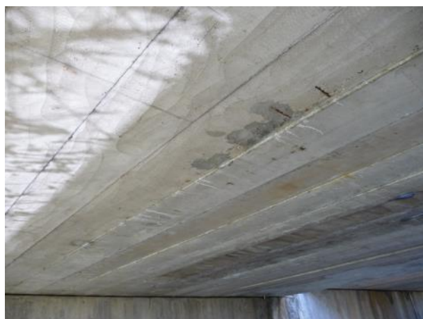
Slika 1.12 Izložena korodirana armatura
