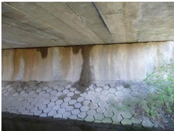
Slika 1.14 Tragovi vlaženja po upornjacima
