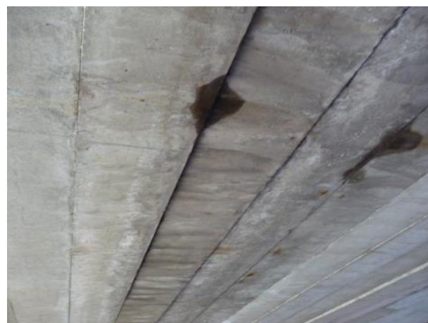
Slika 1.13 Tragovi vlaženja po nosačima
