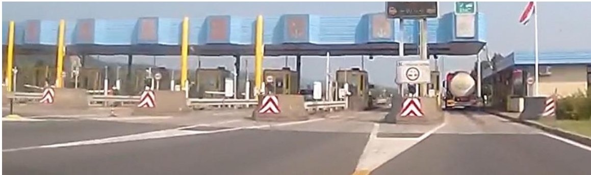
Slika 2. Postojeće betonske barijere sa K08 i K16 na ulazu na naplatne kućice.
