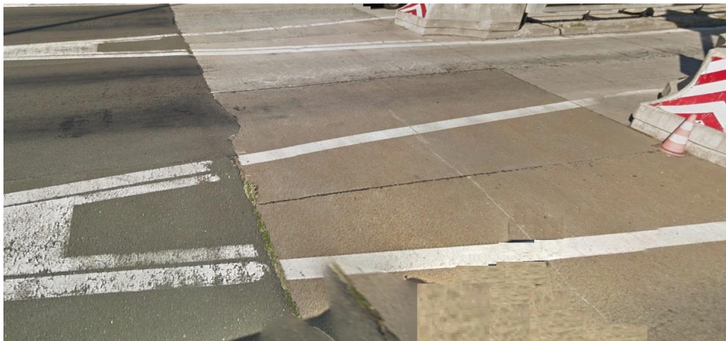
Slika 3. Asfalt i betonska podloga – smjer Varaždin.
