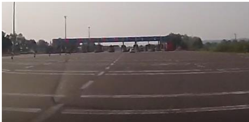
Slika 4. Postojeće trake za zvučno upozorenje - smjer Zagreb.
