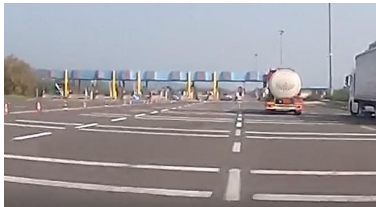
Slika 1. Postojeće stanje trake za zvučno upozorenje - smjer Varaždin.
