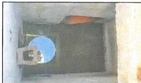
Slika 4. Unutrašnjost okna RO 26-D1
