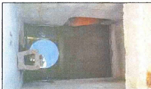
Slika 4. Unutrašnjost okna RO 26-D1
