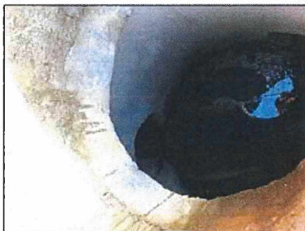
Slika 2. Unutrašnjost okna RO 24
