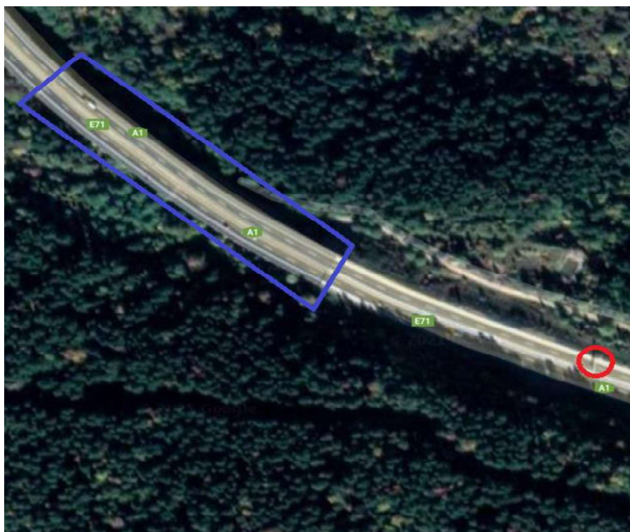
Slika 1. Plavo – vijadukt Pećine u km 154+200, Crveno – portal predmet sanacije.
