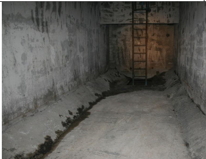
Pregled ulaznog dijela u separator – ljestve s leđobranom
