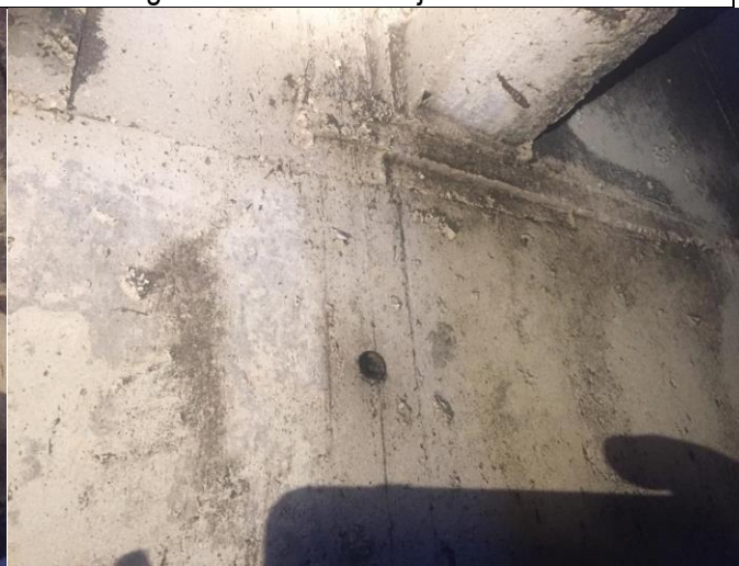
Pregled uočenih cijevi u zidovima separatora
