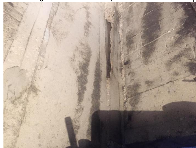
Pregled uočenih oštećenja spojeva zidova
