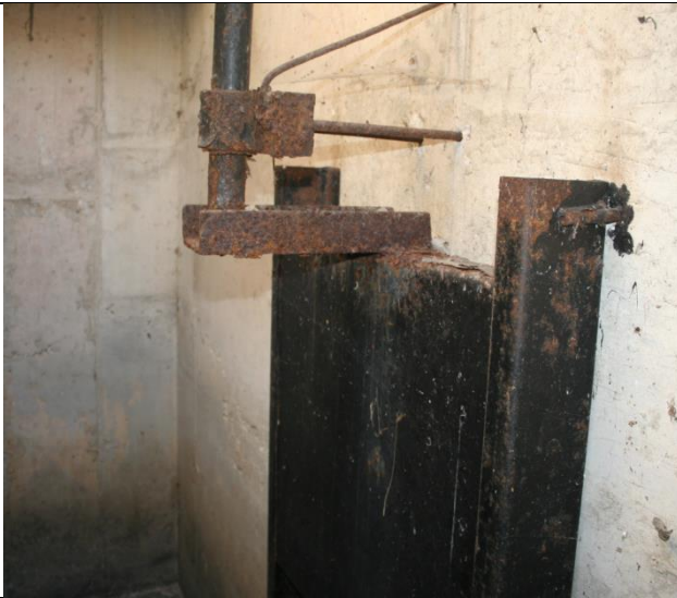
Pregled zapornice ulaz
