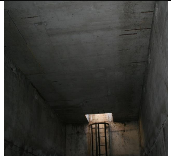
Pregled stijenke zidova i stropne ploče separatora
