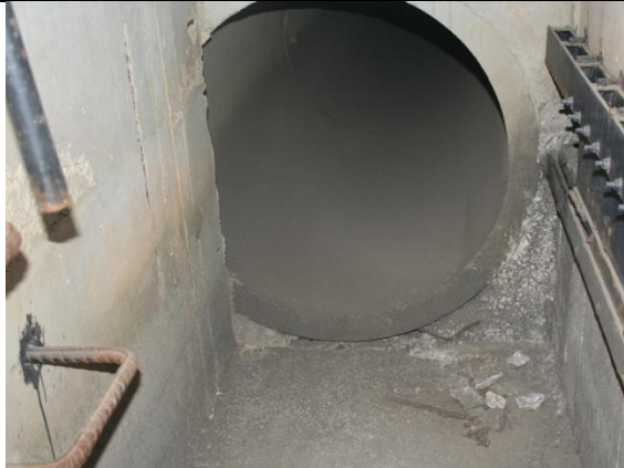
Pregled zida i penjalica izljevno okna
