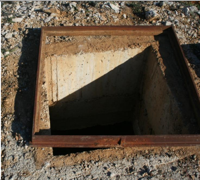
Pregled izljevno okna – ulaz
