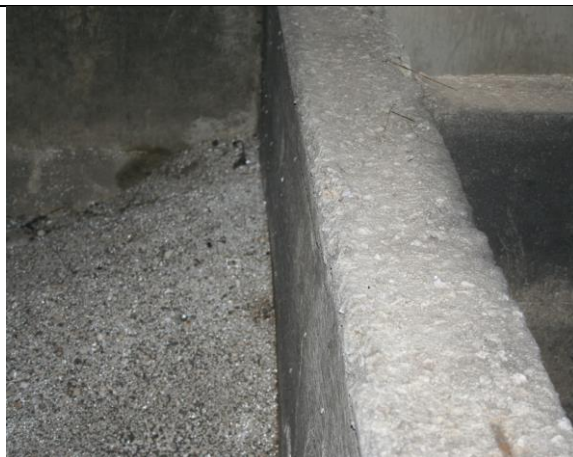
Pregled prelivne građevine
