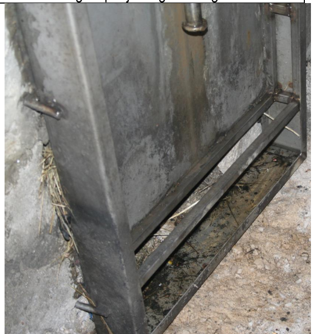
Pregled zapornice- ulaz
