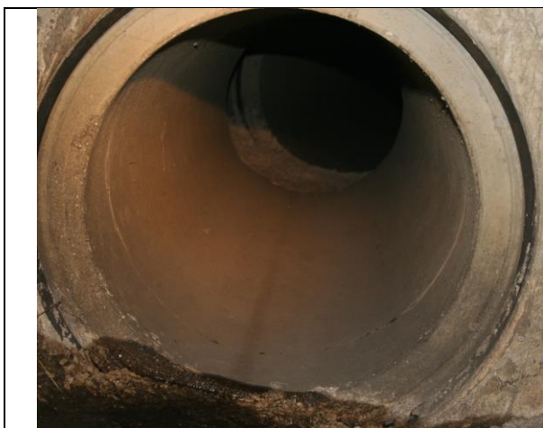
Pregled cijevi izljevnog okna
