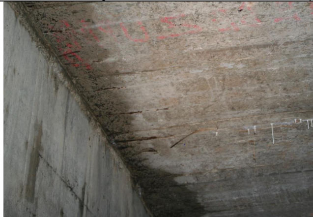
Pregled stropne ploče separatora
