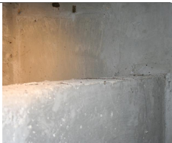
Pregled preljevnog zida
