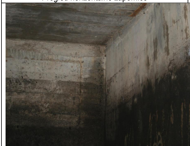
Pregled stijenke zidova i stropne ploče separatora
