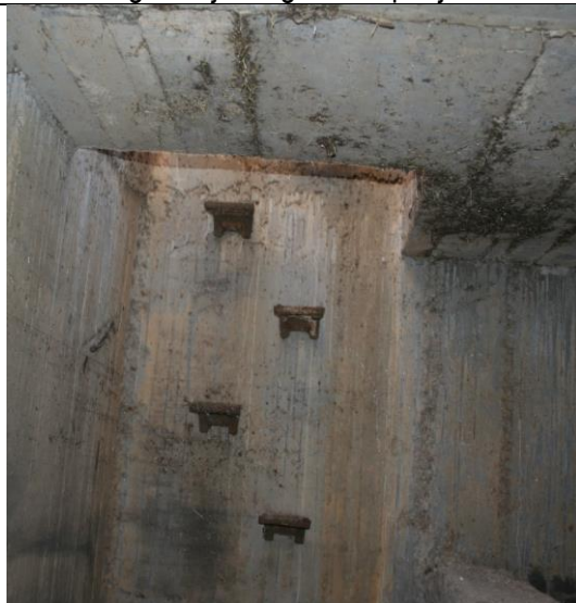
Pregled preljevnog okna - ulaz
