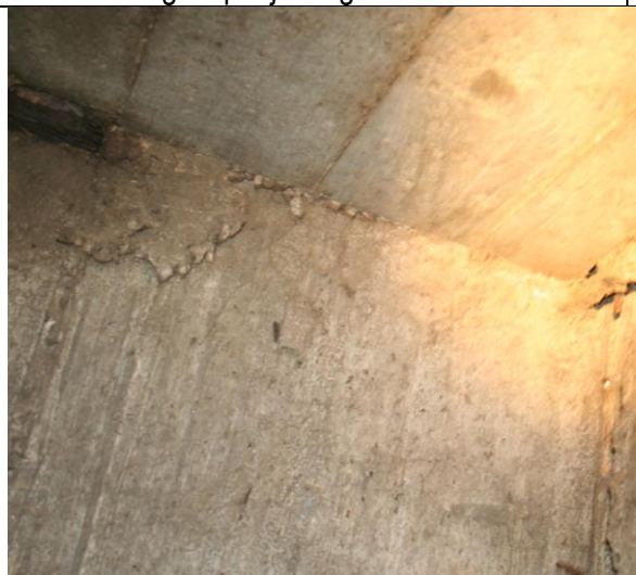
Pregled preljevnog okna
