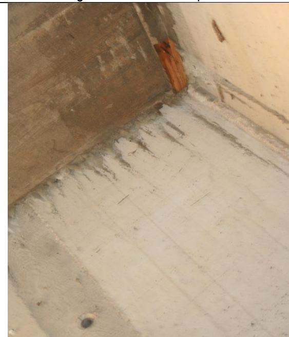
Pregled izljevnog okna
