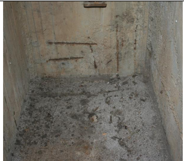
Zidovi i dno uljevnog okna
