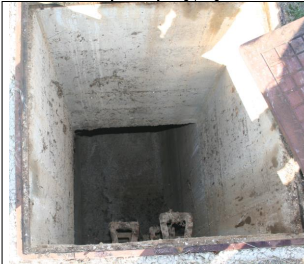
Pregled uljevnog okna - penjalice
