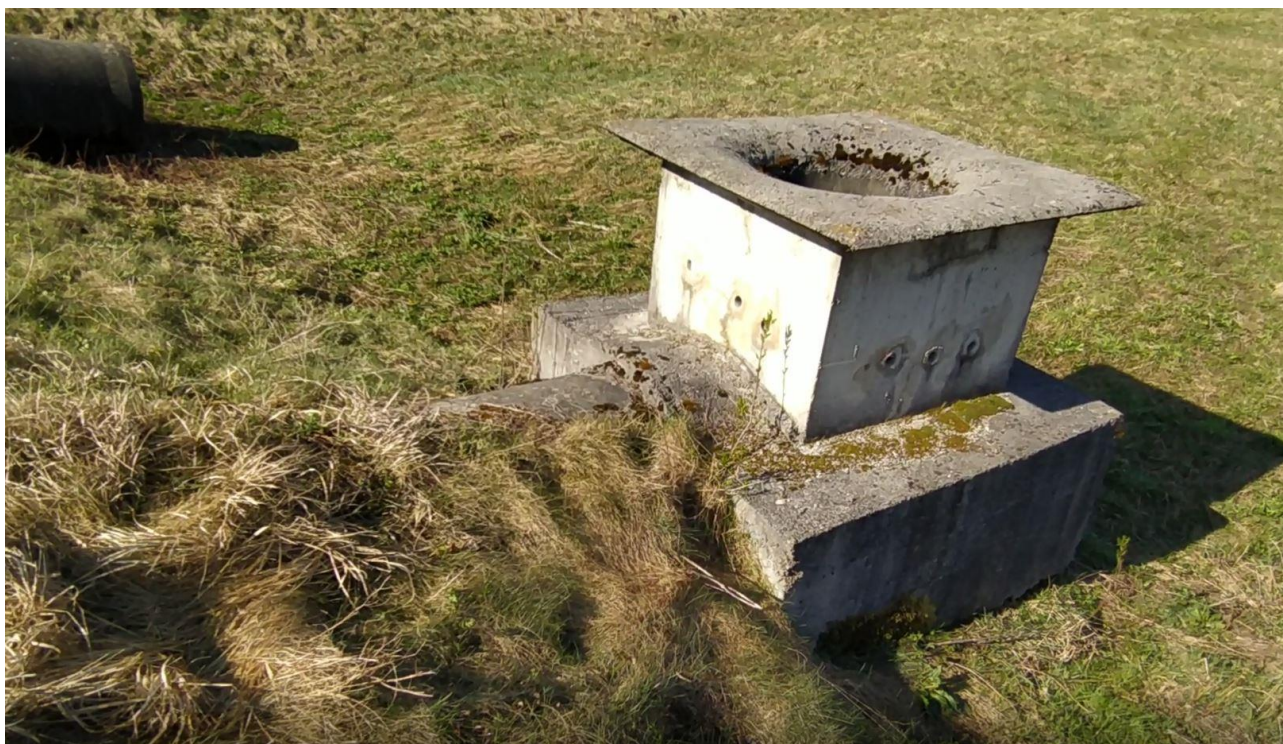
Slika 5. Preljev – izljevna građevina i izlazna cijev u lijevom kutu fotografije
